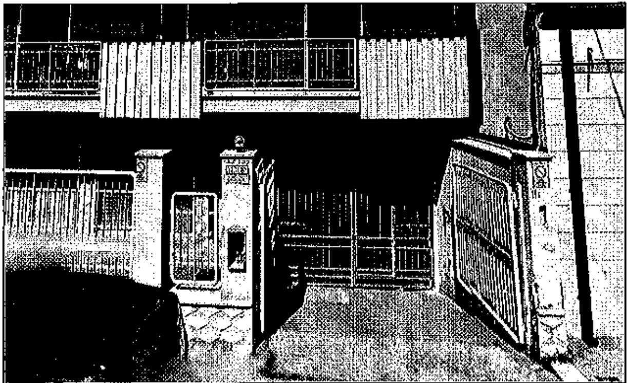
Figura 2. Accesso al civico 9 di Via Don Minzoni che conduce al piano seminterrato del fabbricato al quale appartiene il box auto di cui al lotto A.
