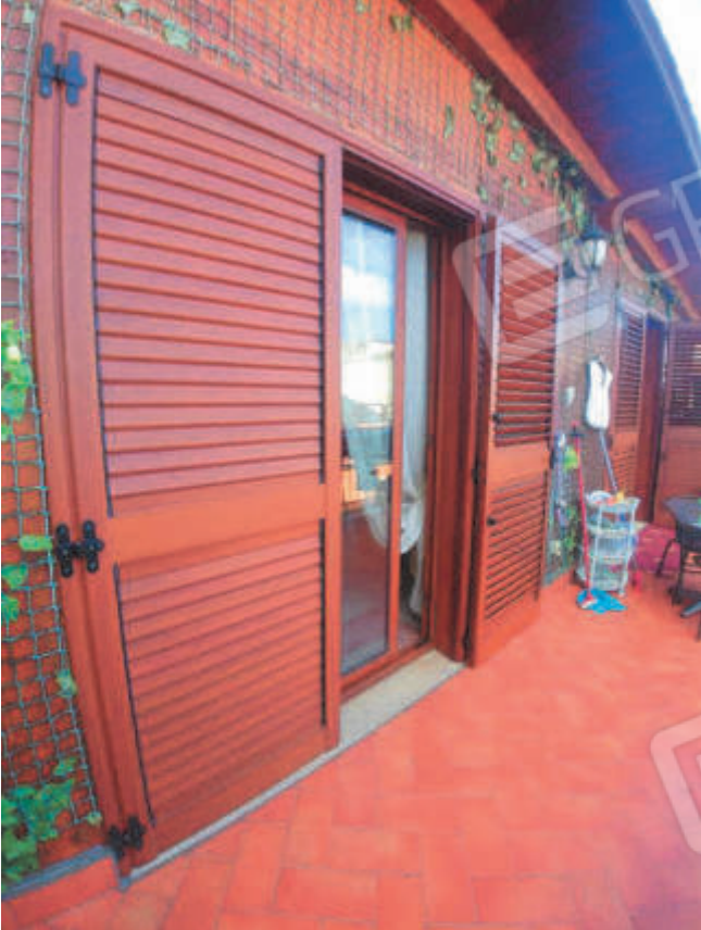
Figura 14: balcone su via M. V. Campo
