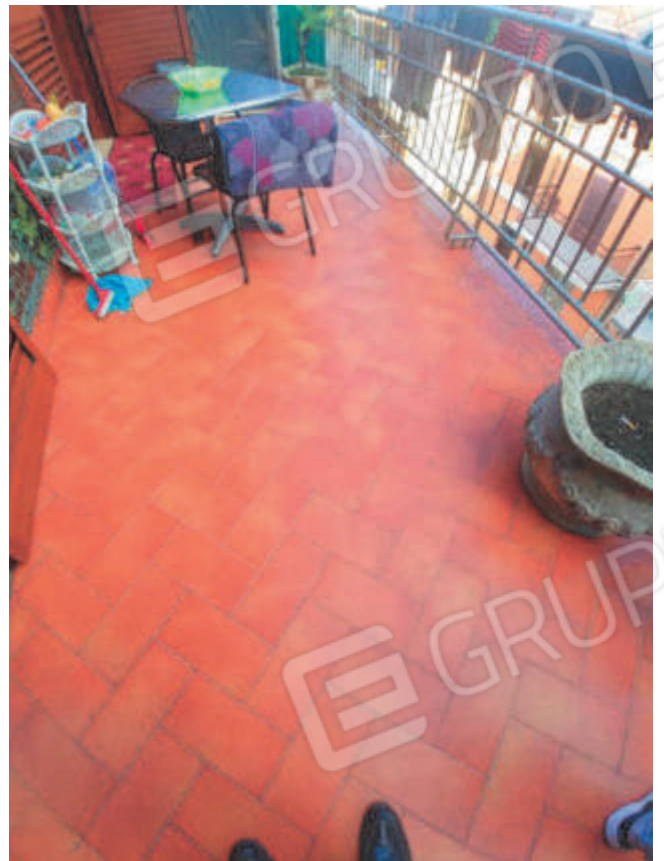
Figura 17: balcone su via M. V. Campo
