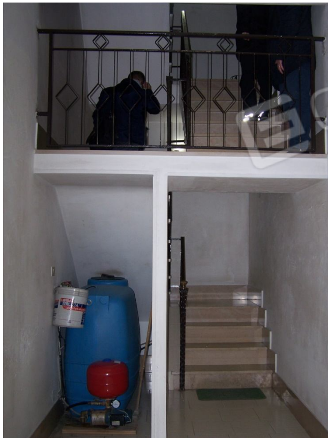
Foto n. 2: Vano scala immobile via Croghan 32 San Severo NCEU F31 P.IIa 10556 sub 3
