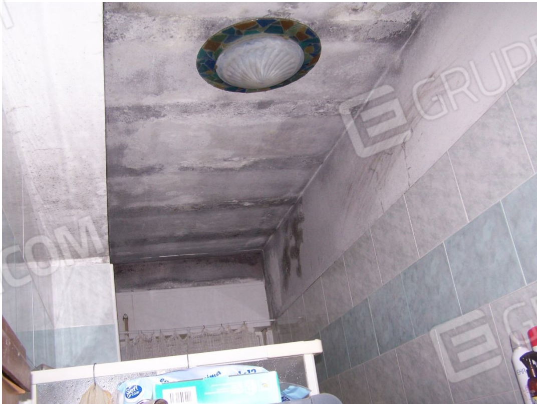
Foto n. 14: Danni infiltrazioni bagno immobile via Croghan 32 S. Severo NCEU F31 P.IIa 10556 sub 3
