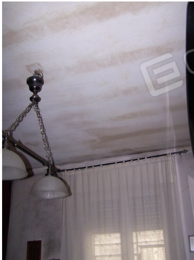
Foto n. 12: Danni infiltrazioni camera immobile via Croghan 32 S. Severo NCEU F31 P.IIa 10556 sub 3
