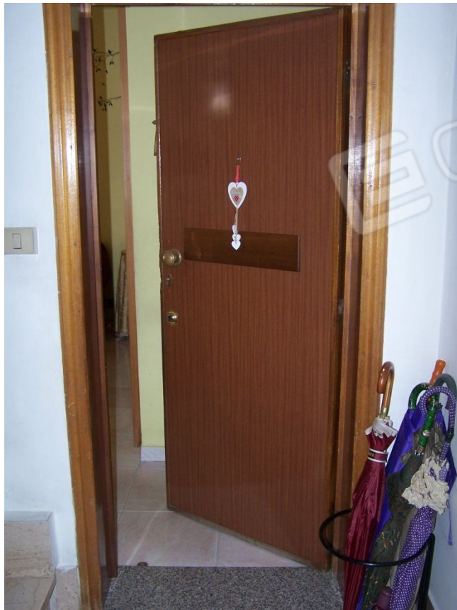
Foto n. 4: Ingresso immobile via Croghan 32 San Severo NCEU F31 P.Ila 10556 sub 3
