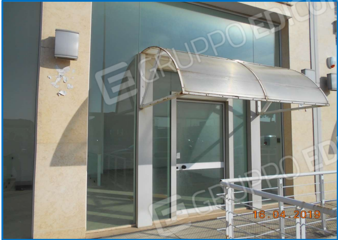
FOTO N.5: ingresso in piano terra all'immobile in sub 15 – lotto n.1
