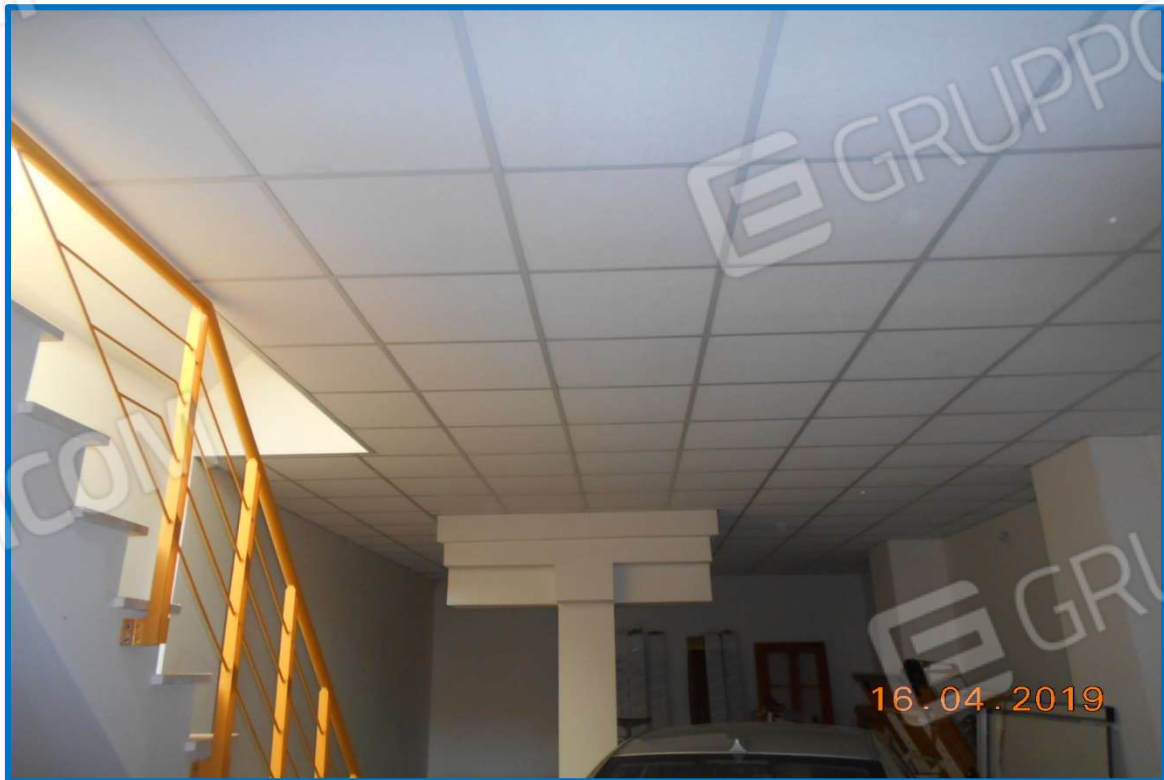
FOTO N.8: interni piano interrato immobile in sub 15 – lotto n.1.
