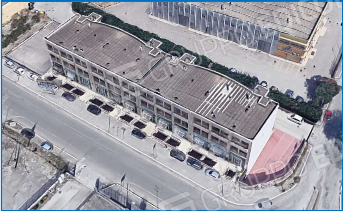
FOTO N.1: vista aerea del fabbricato di via Manfredonia (fonte Google maps).
