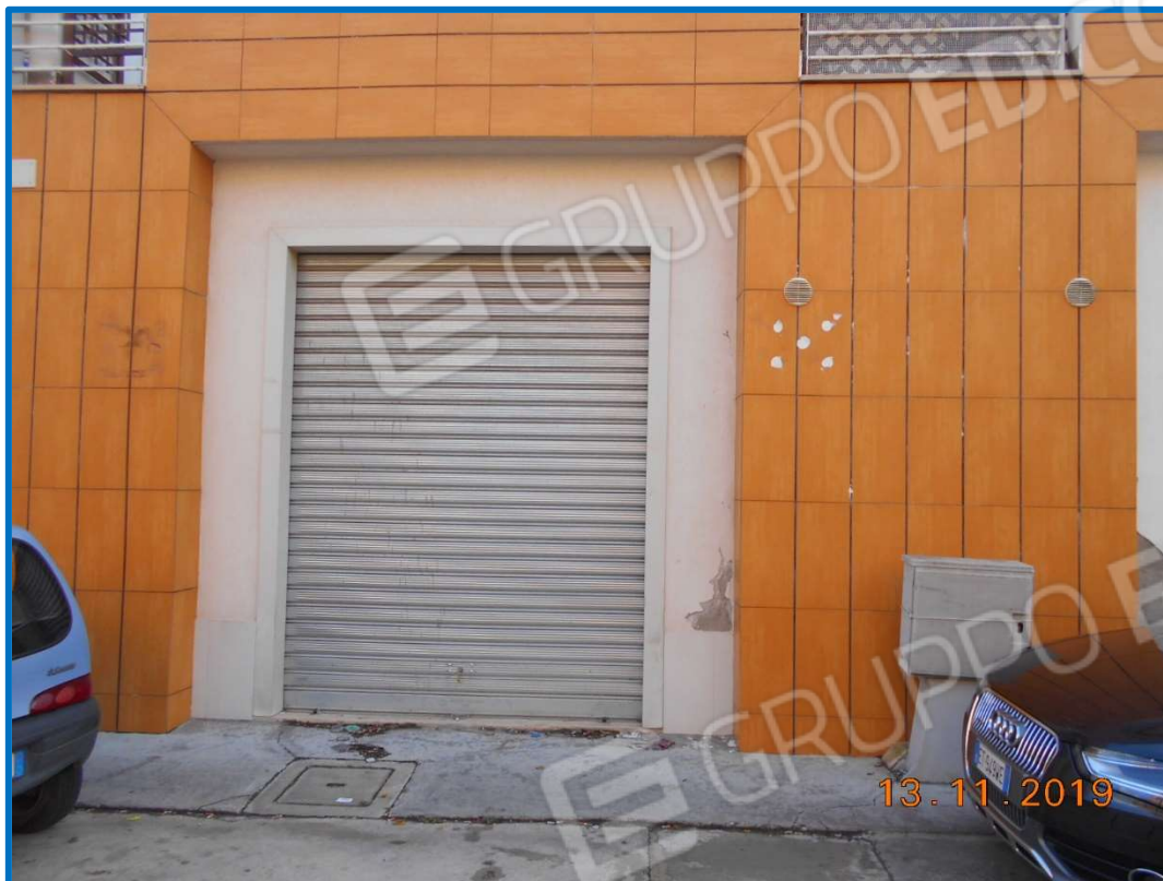
FOTO N.3: ingresso all'immobile in piano terra sub 26 – Lotto n.5
