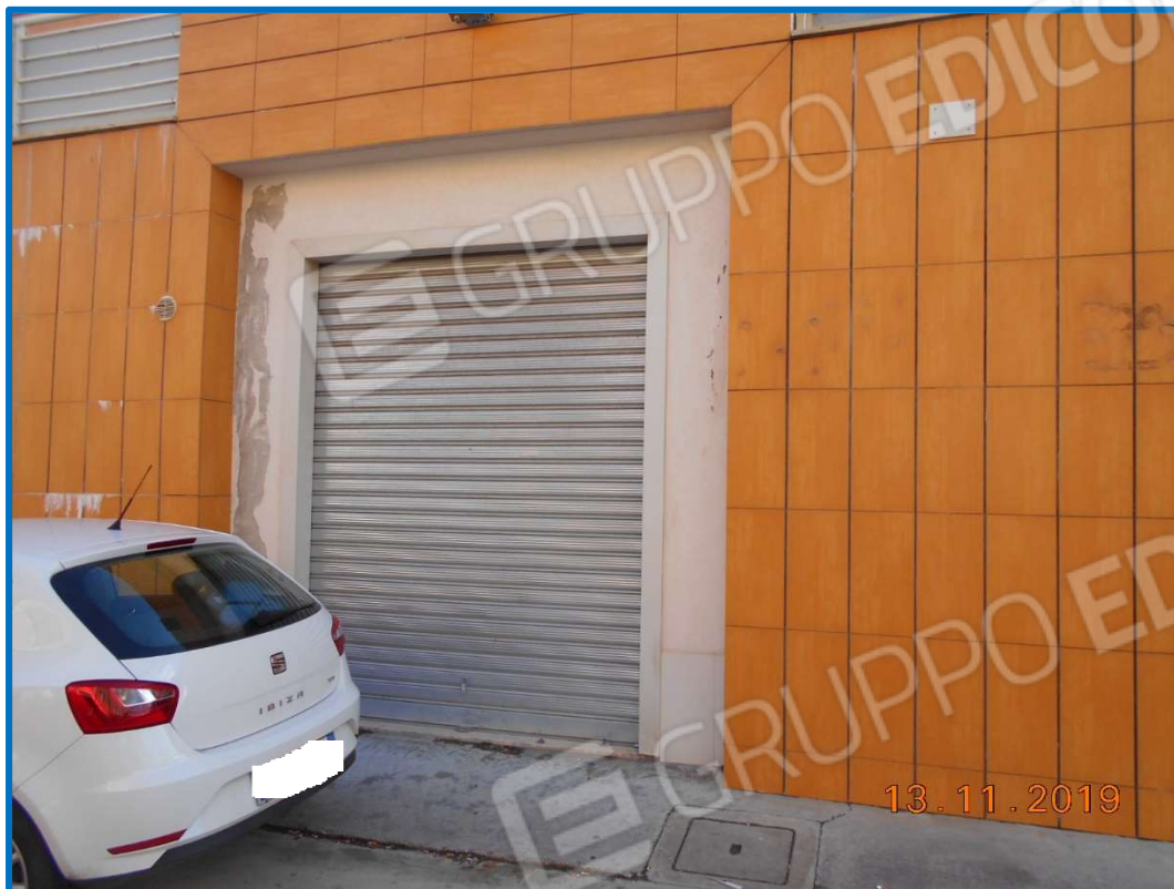
FOTO N.7: ingresso all'immobile in piano terra sub 27 – Lotto n.6.
