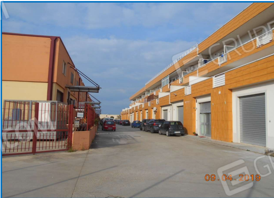
FOTO N.2: vista del fronte N-O del blocco di via delle Casermette dove sono ubicati i lotti nn.5, 6, 7, 8.
