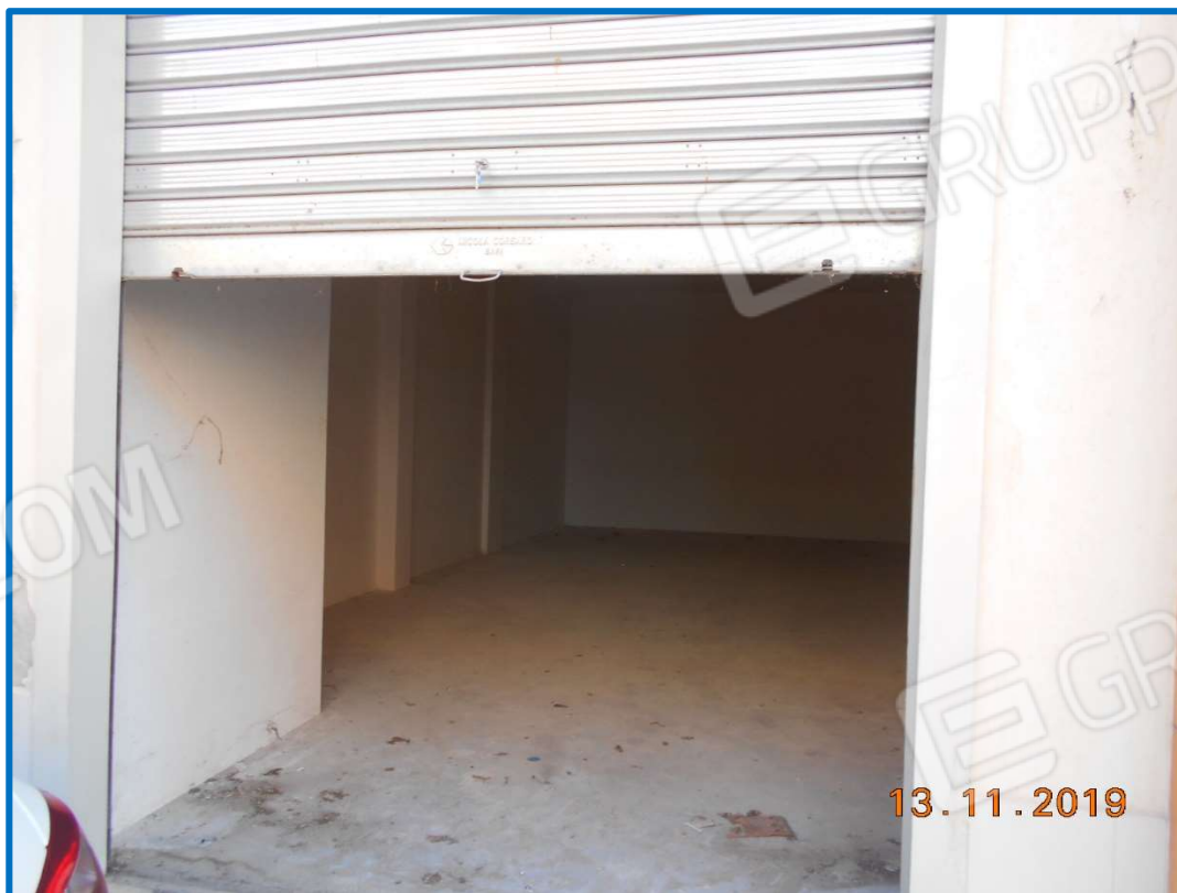
FOTO N.8: ingresso all'immobile in piano terra sub 27 – Lotto n.6.
