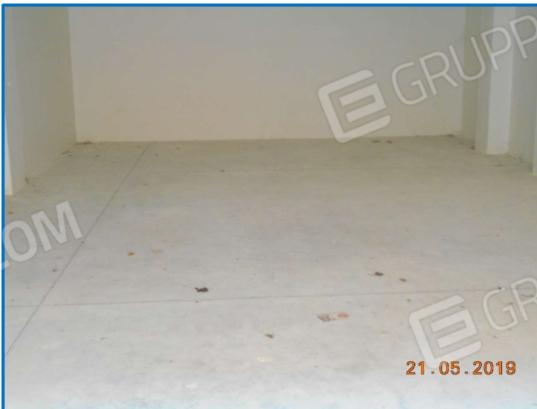
FOTO N.16: interno dell'immobile in piano terra sub 30 – Lotto n.8.
