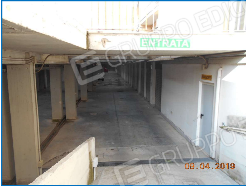
FOTO N.3: primo tratto della corsia di manovra vista dalla rampa di accesso ai box.
