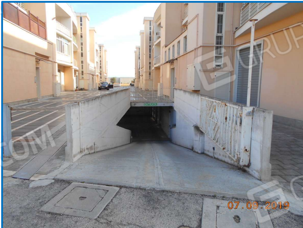
FOTO N.2: vista del varco della rampa di accesso ai box del piano interrato.
