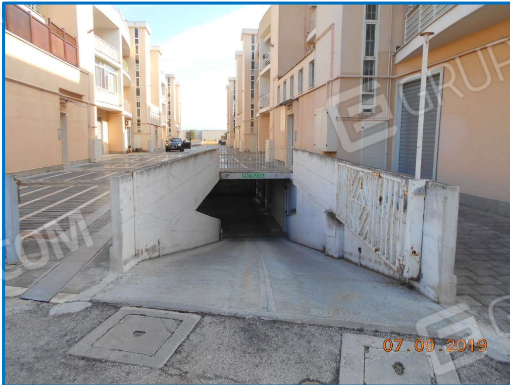
FOTO N.2: vista del varco della rampa di accesso ai box del piano interrato.
