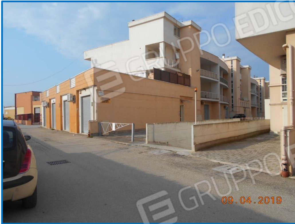
FOTO N.1: ubicazione della rampa di accesso ai box del piano interrato da trav. Via delle Casermette.
