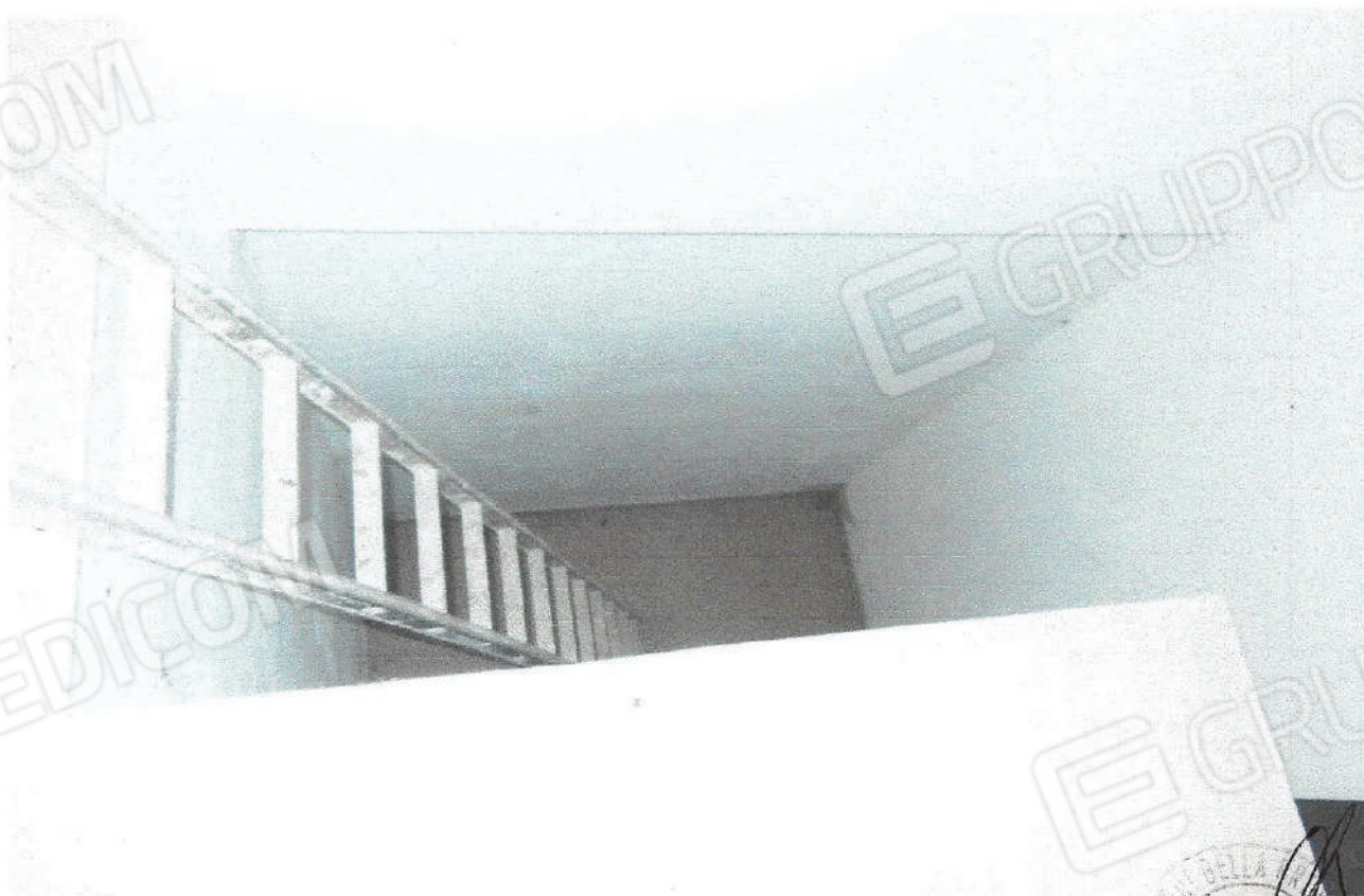
8 – Part. vano scala locale commerciale in fase di ultimazione via L. B. Alberti
