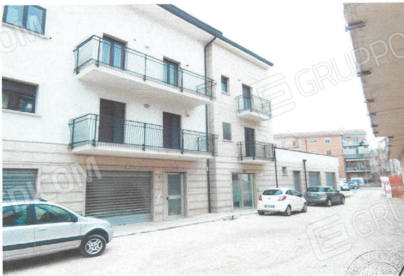
4 – Part. prospetto principale locale commerciale in fase di ultimazione via L. B. Alberti
