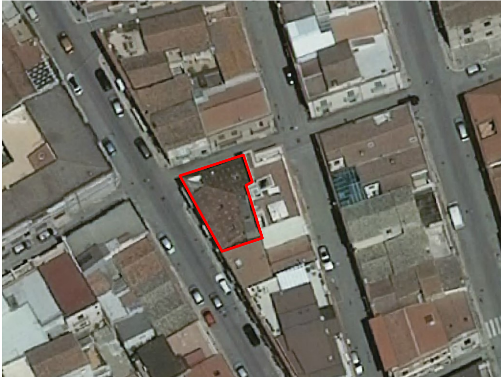
Figura 1. Fotografia aero-planimetrica del fabbricato.
