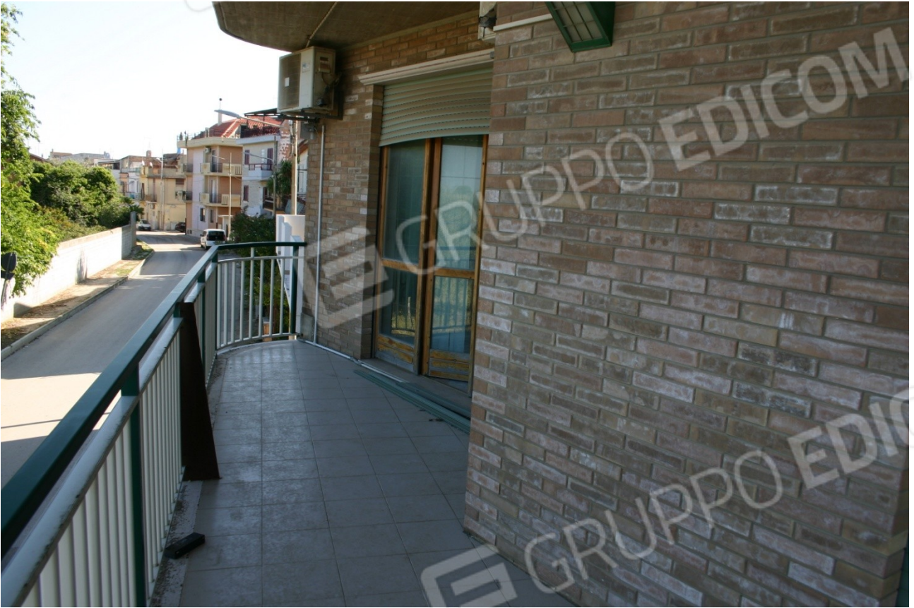
BALCONE AL PRIMO PIANO
