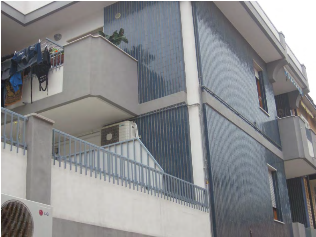
FOTO N. 1 Edificio del bene staggito.
