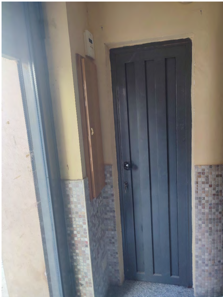
FOTO N. 5. Porta ingresso locale wc.
