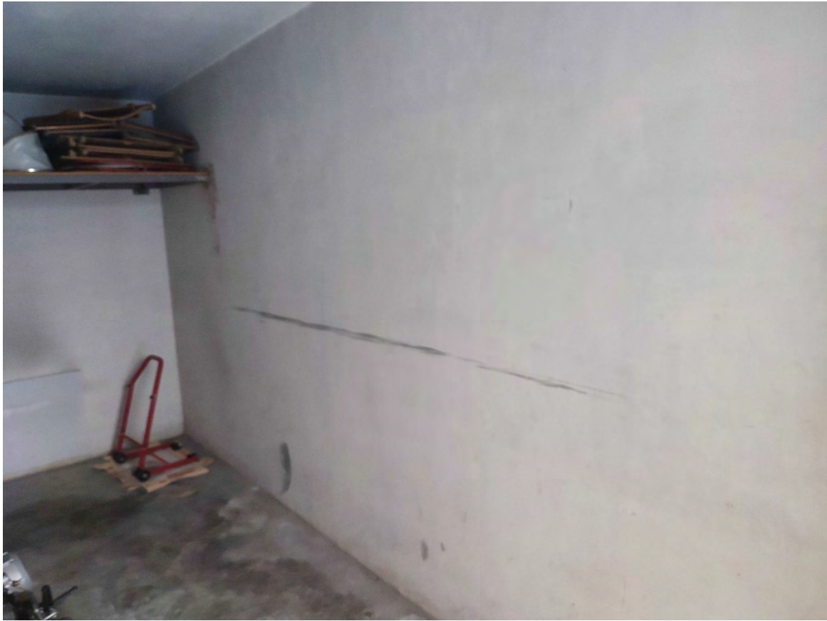
FOTO N. 3. Particolare interno box.
