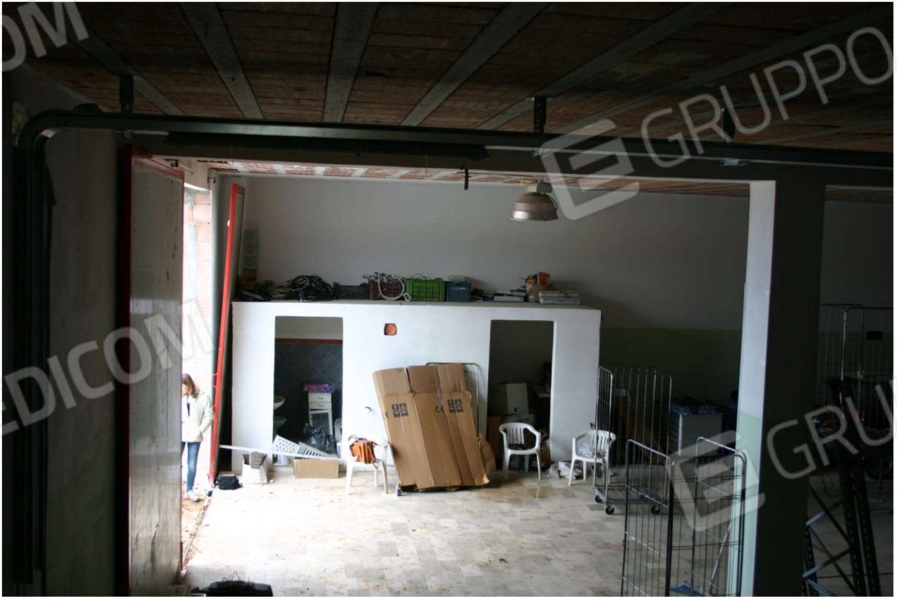
VISTA INTERNA DELLA VASCA INSISTENTE PER INTERO SULLA P.LLA 92 - WC e SPOGLIATOIO
