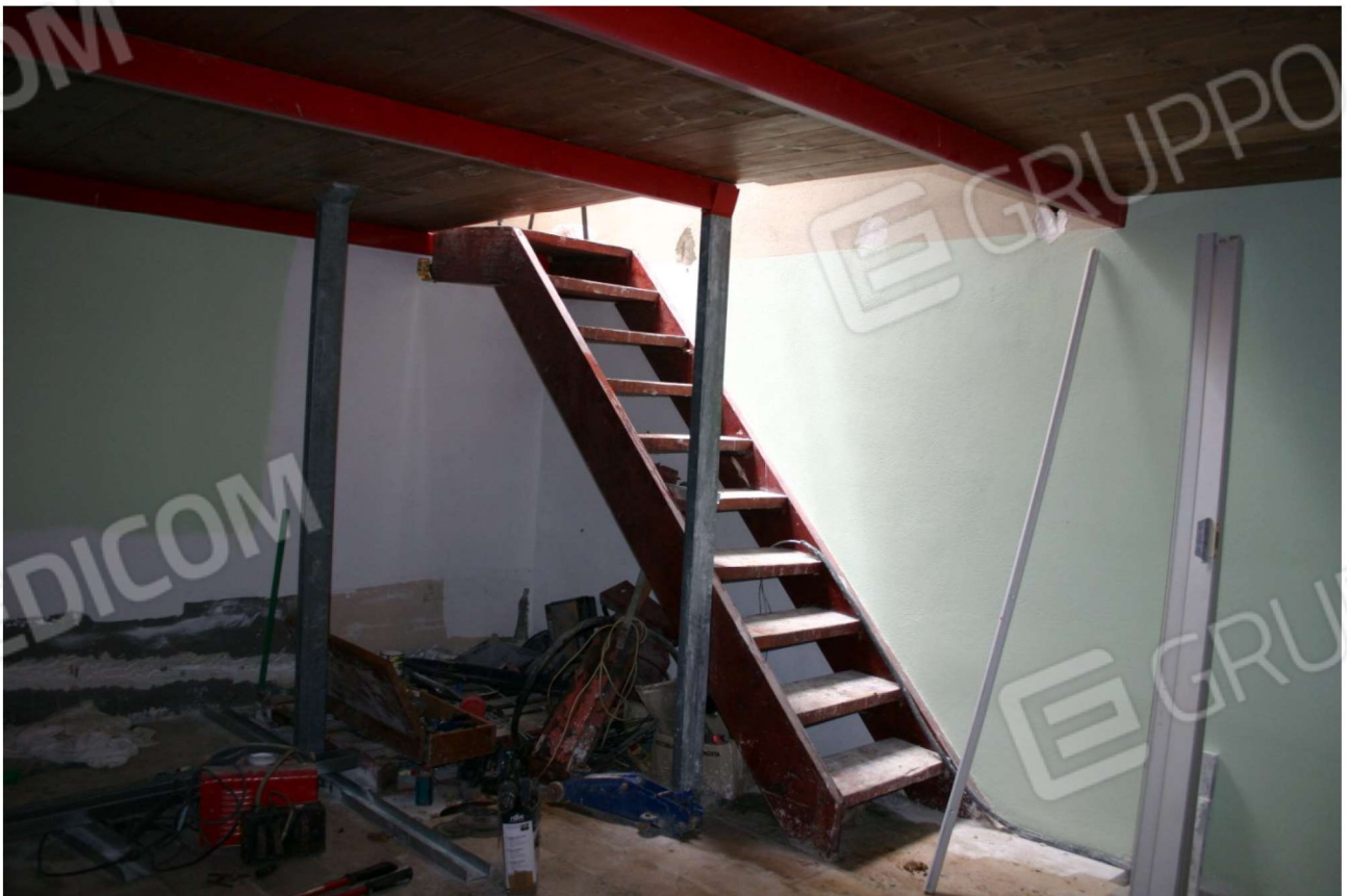
VISTA INTERNA DELLA VASCA INSISTENTE PER INTERO SULLA P.LLA 92 - SOPPALCO
