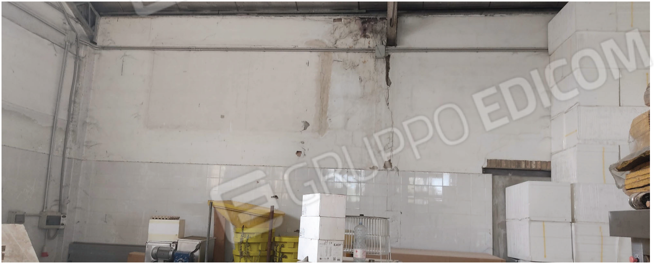
Vista interna del capannone Foto n.10
