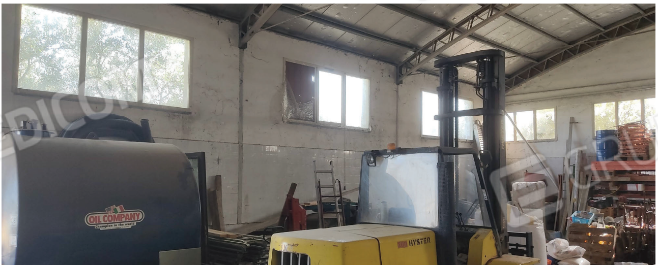
Vista interna del capannone Foto n.9
