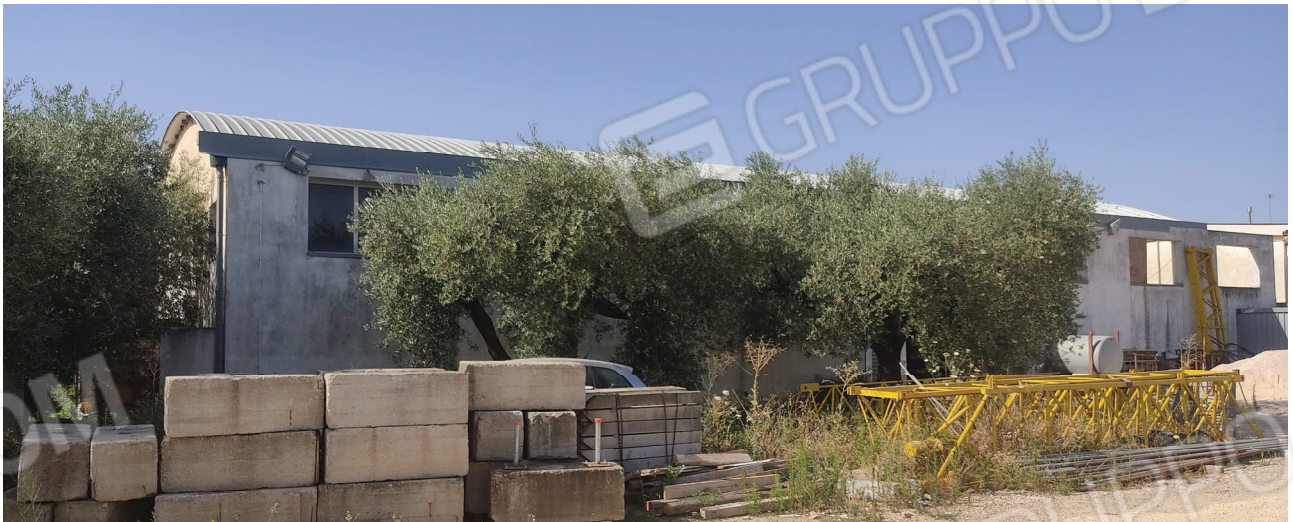
Vista esterna del capannone Foto n.5
