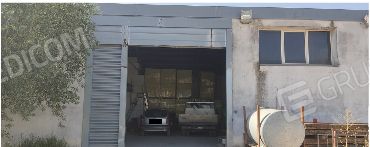
Ingresso del capannone Foto n.6
