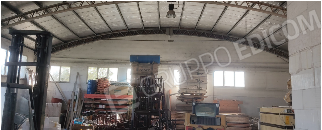
Vista interna del capannone Foto n.7
