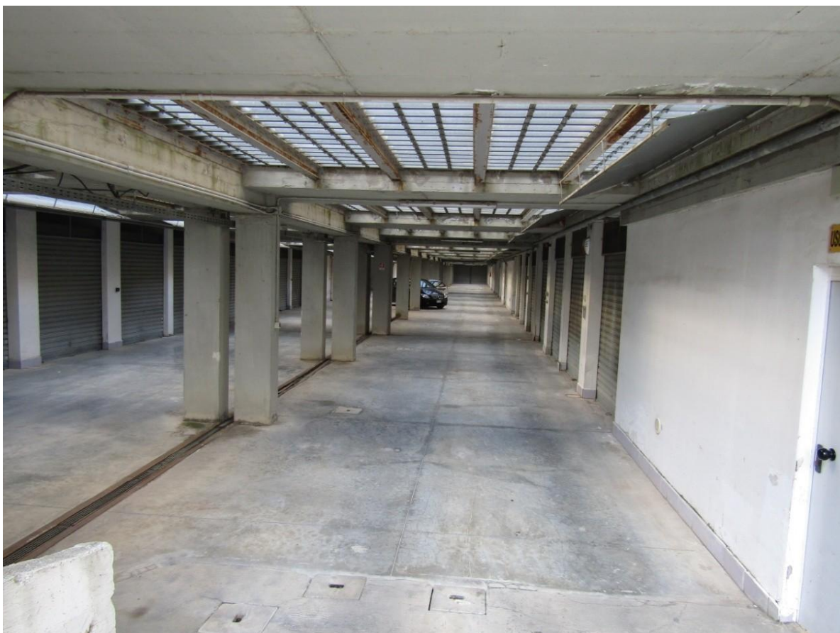
FOTO 32.3 - LOTTO 32 – BOX AUTO IN FOGGIA – PRIMO PIANO INTERRATO
