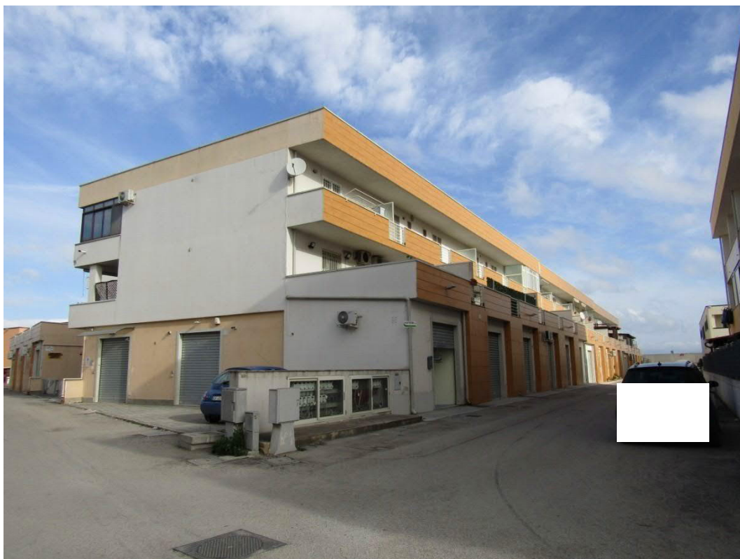
FOTO 31.1 - LOTTO 31 - BOX AUTO IN FOGGIA - FABBRICATO B
