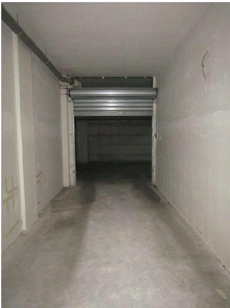
FOTO 31.7 - LOTTO 31 - BOX AUTO IN FOGGIA - PRIMO PIANO INTERRATO - INTERNO
