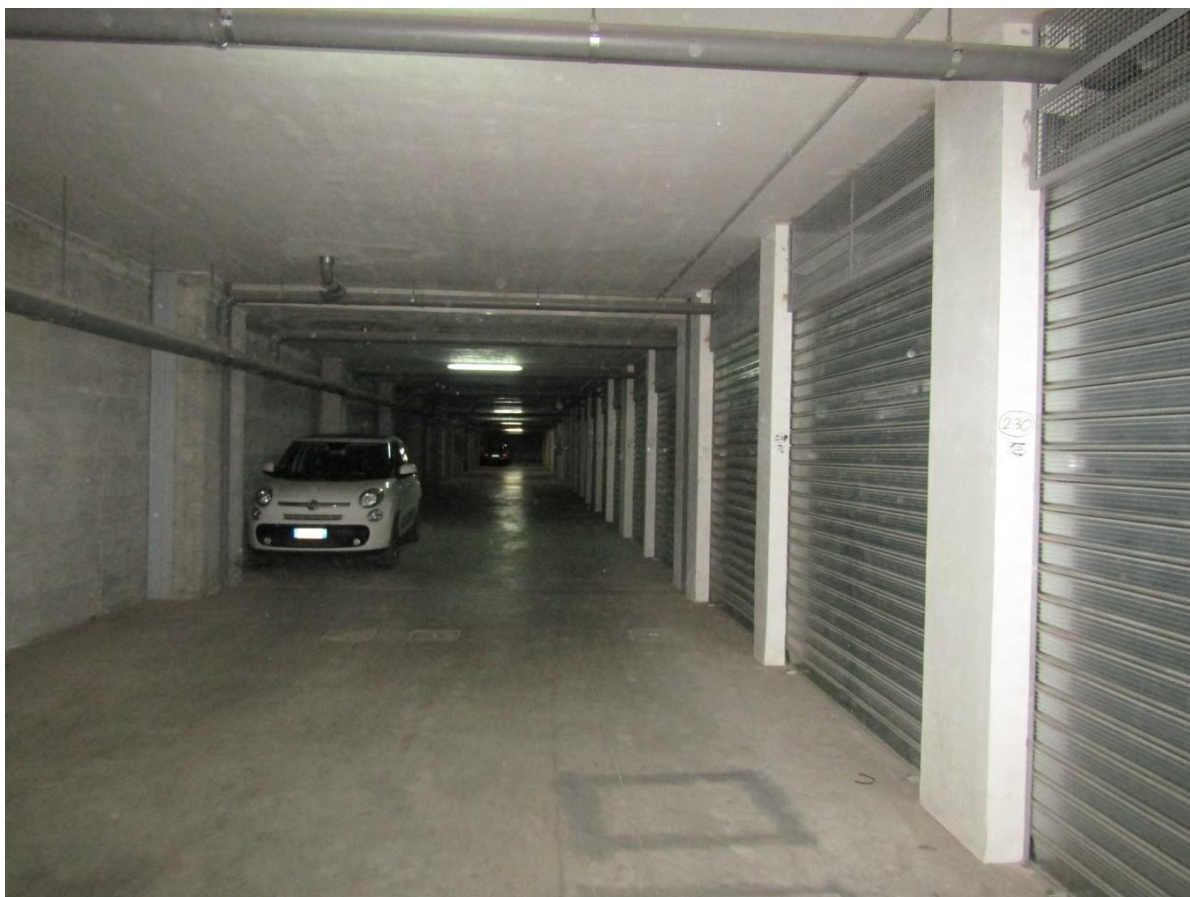
Foto 31.4 - LOTTO 31 - BOX AUTO IN FOGGIA - PRIMO PIANO INTERRATO - CORSIA DI MANOVRA
