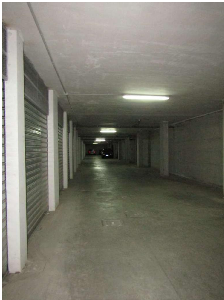
FOTO 7.4 - LOTTO 7 – BOX AUTO IN FOGGIA – PRIMO PIANO INTERRATO – CORSIA DI MANOVRA
