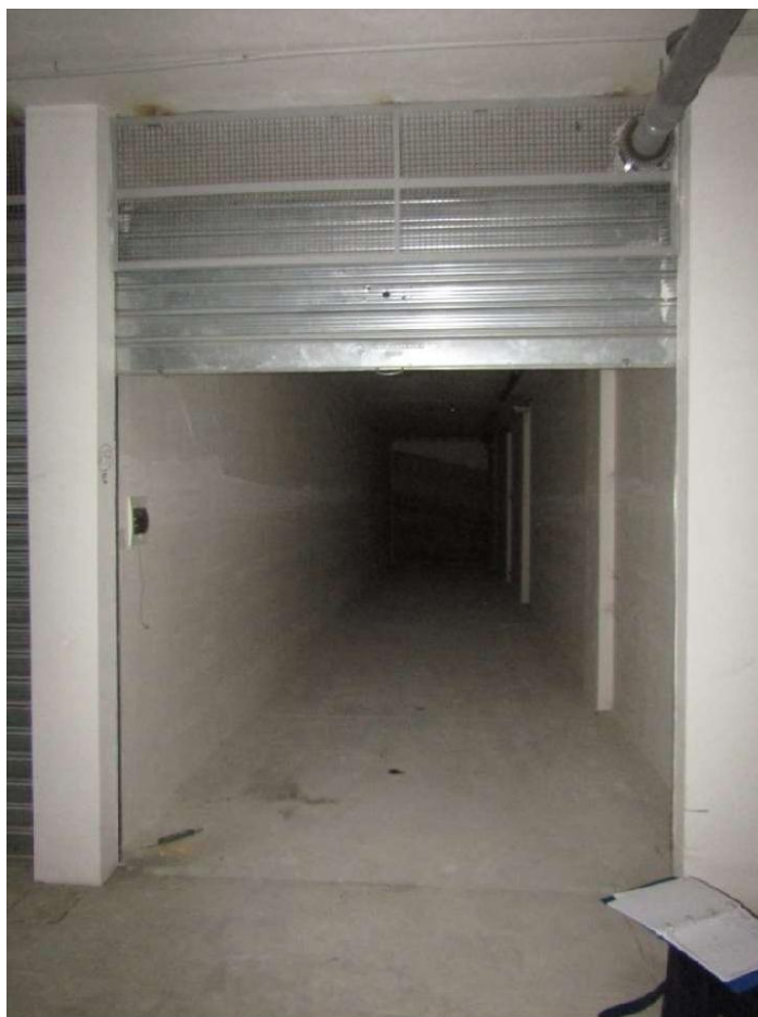
FOTO 8.5 – LOTTO 8 – BOX AUTO IN FOGGIA – PRIMO PIANO INTERRATO – INGRESSO
