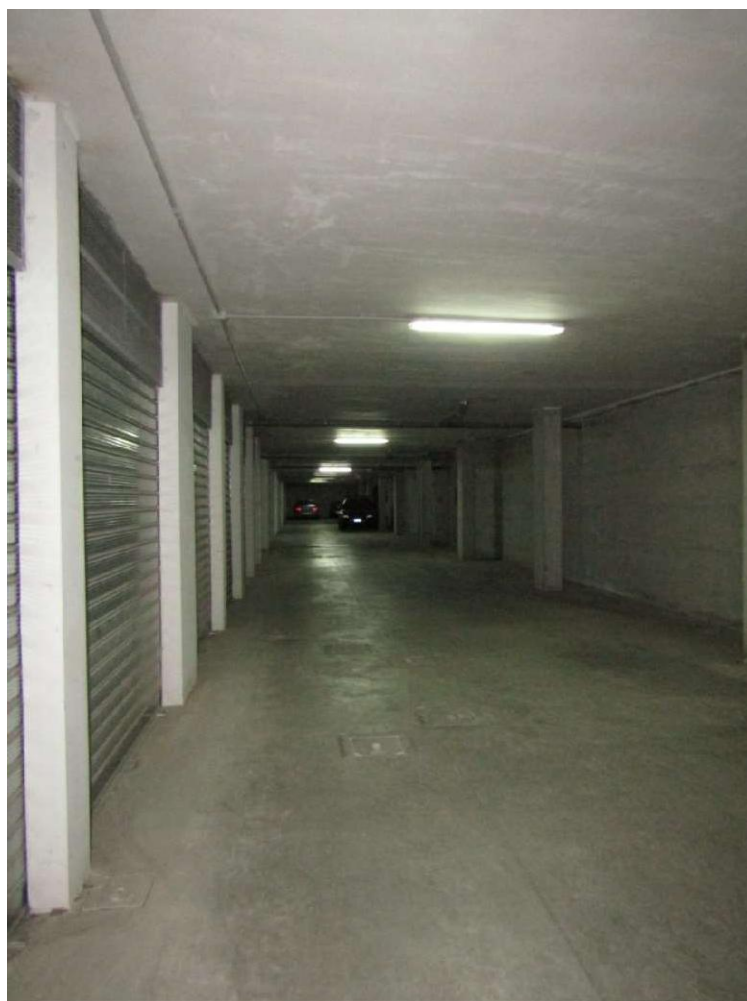
FOTO 8.4 - LOTTO 8 – BOX AUTO IN FOGGIA – PRIMO PIANO INTERRATO – CORSIA DI MANOVRA
