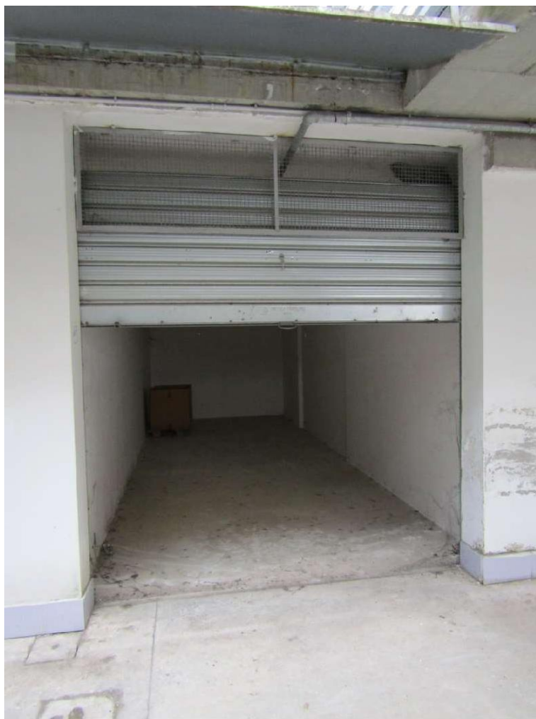
FOTO 12.5 - LOTTO 12 – BOX AUTO IN FOGGIA – PRIMO PIANO INTERRATO – INGRESSO
