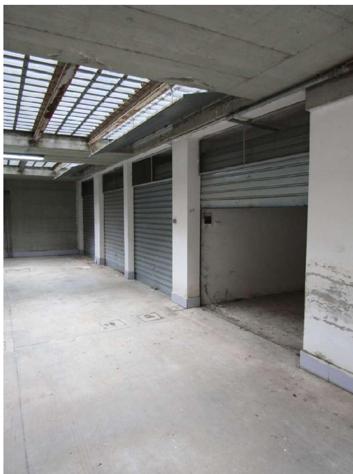
FOTO 12.4 - LOTTO 12 – BOX AUTO IN FOGGIA – PRIMO PIANO INTERRATO – CORSIA DI MANOVRA/INGRESSO
