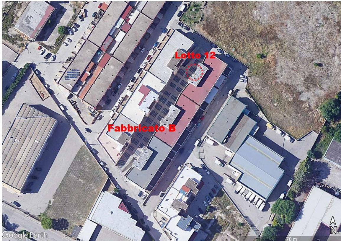
Fig. 1 – LOTTO 12 - Localizzazione dell'immobile all'interno del Fabbricato B sito in Foggia alla via Manfredonia angolo Via delle Casermette - Ortofoto
