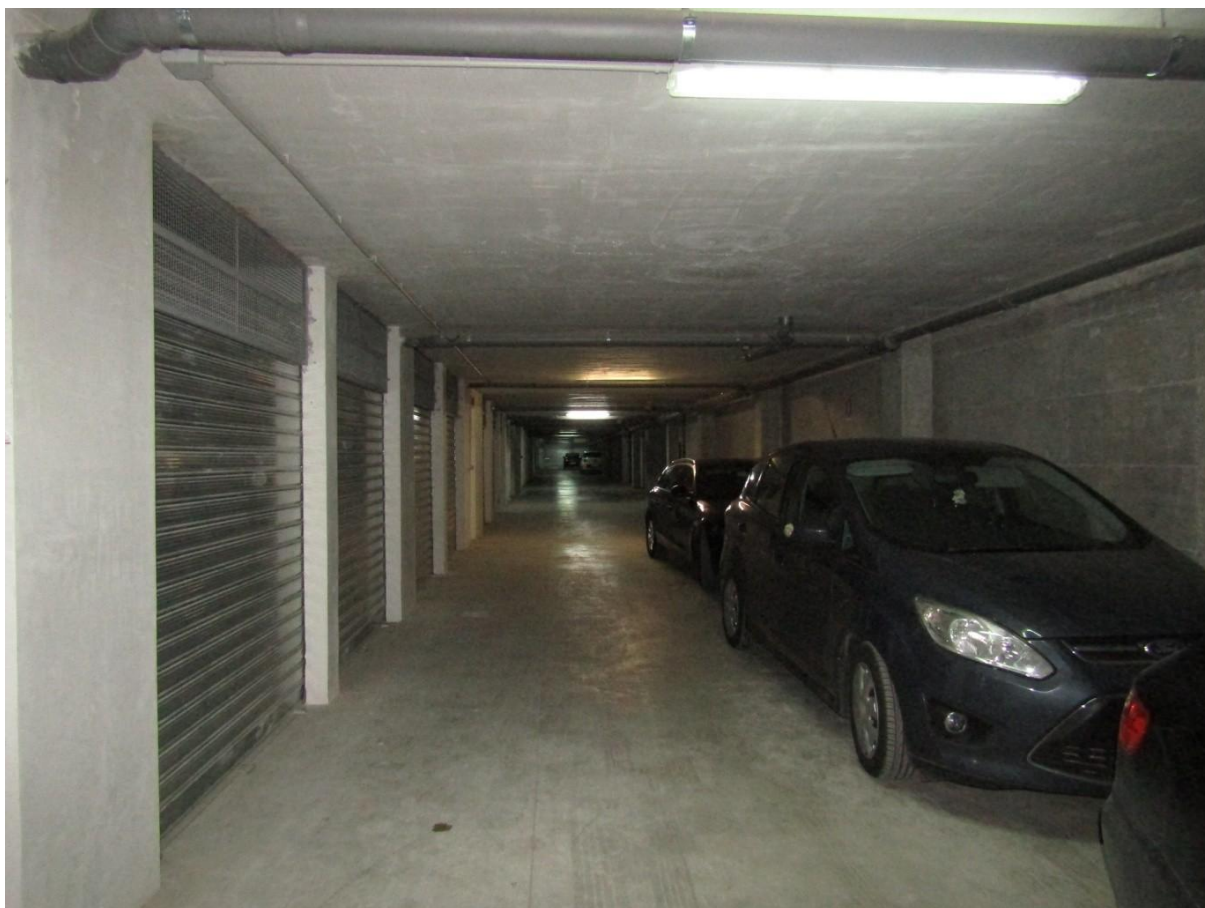
FOTO 18.4 - LOTTO 18 – BOX AUTO IN FOGGIA – PRIMO PIANO INTERRATO – CORSIA DI MANOVRA
