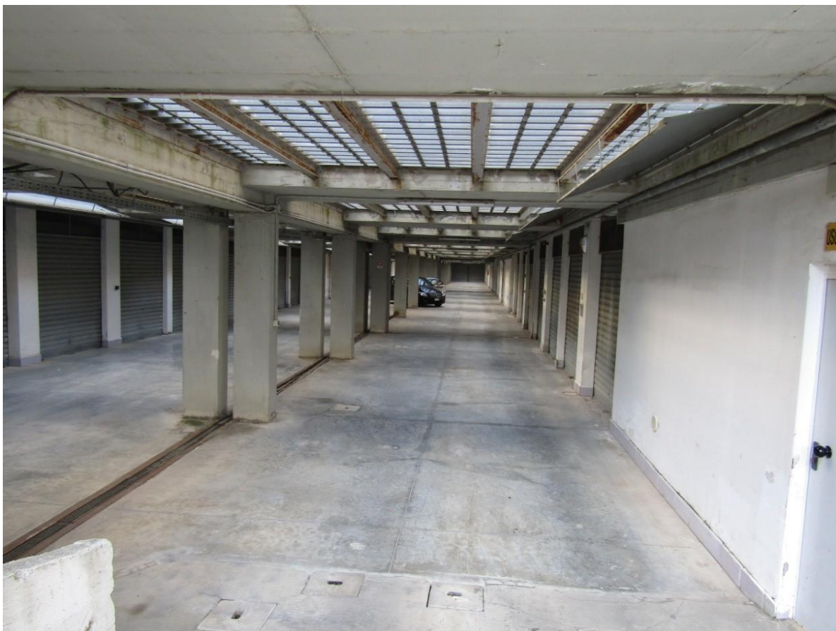
FOTO 21.3 - LOTTO 21 – BOX AUTO IN FOGGIA – PRIMO PIANO INTERRATO
