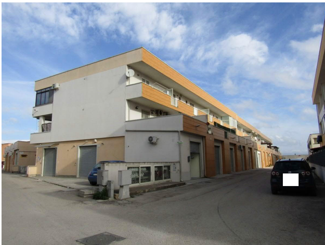
FOTO 22.1 - LOTTO 22 – BOX AUTO IN FOGGIA – FABBRICATO B
