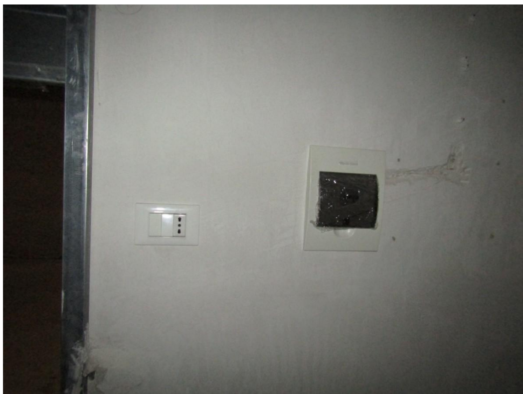
FOTO 22.10 - LOTTO 22 – BOX AUTO IN FOGGIA – PRIMO PIANO INTERRATO – INTERNO
