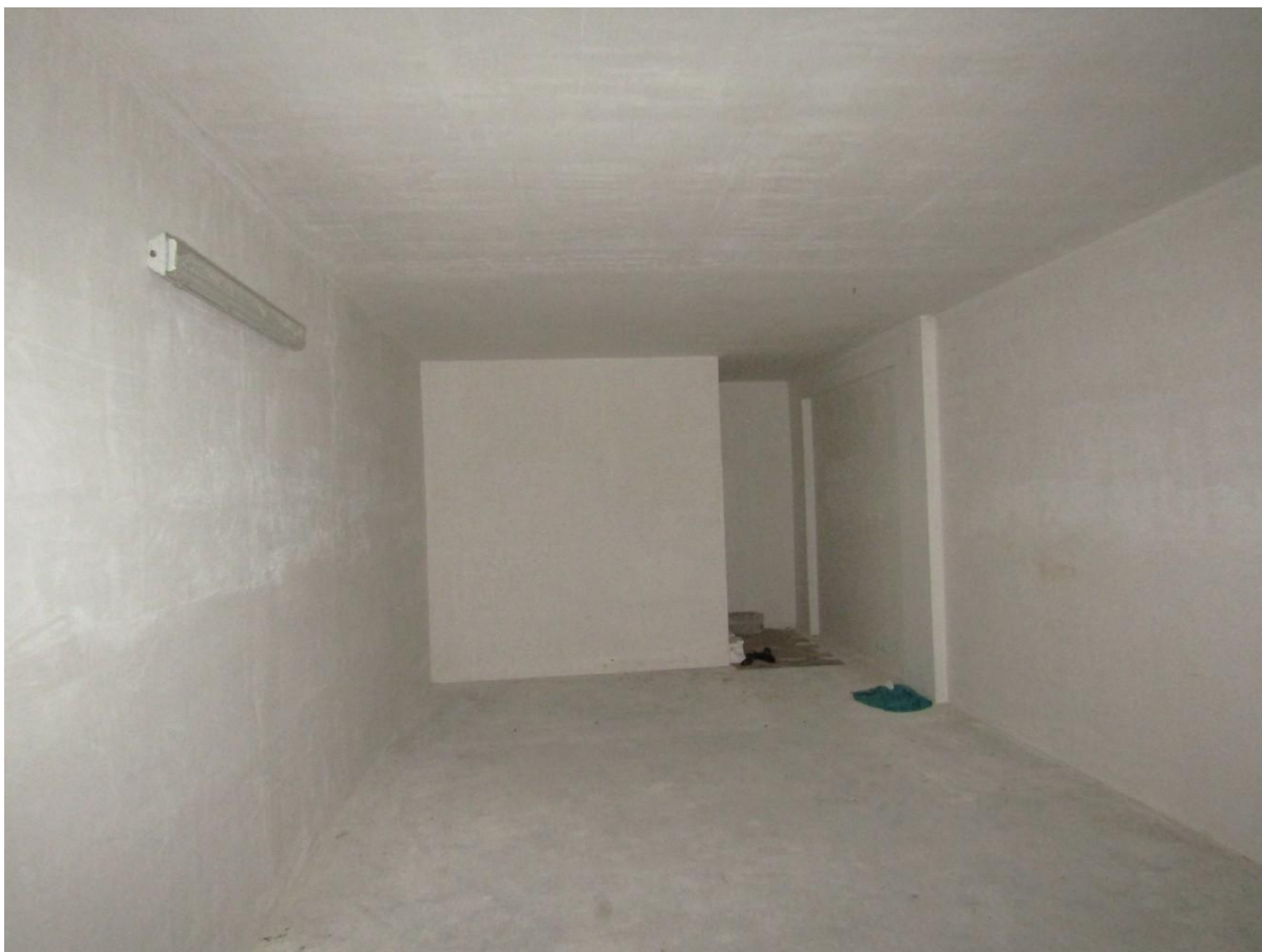
FOTO 22.7 - LOTTO 22 – BOX AUTO IN FOGGIA – PRIMO PIANO INTERRATO – INTERNO
