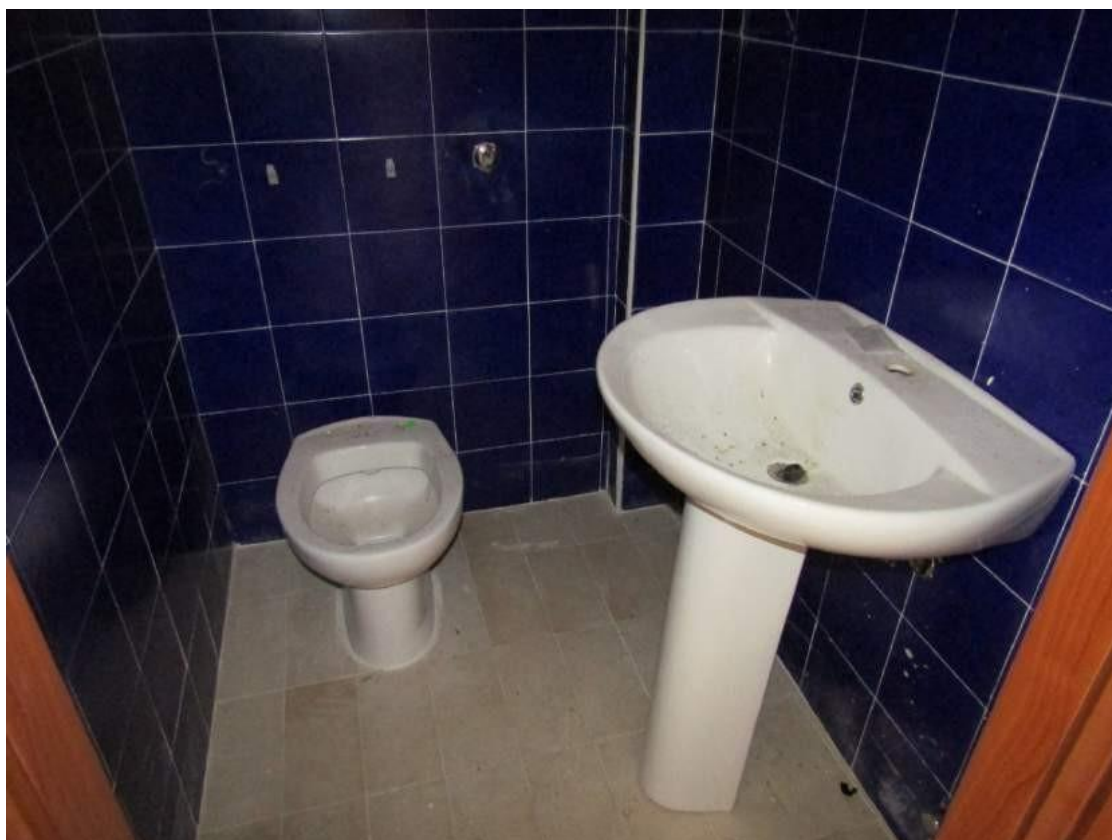
FOTO 3.8 - LOTTO 3 - LABORATORIO ARTIGIANALE IN FOGGIA - BAGNO
