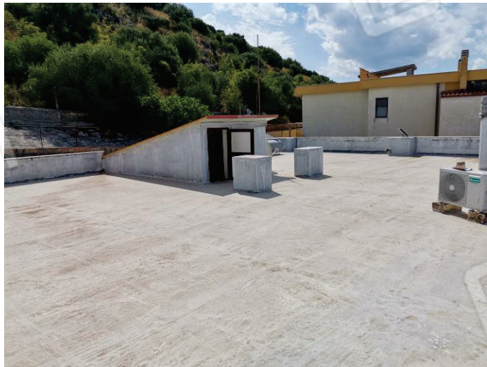
LOTTO 4 il lastrico solare sub 8
