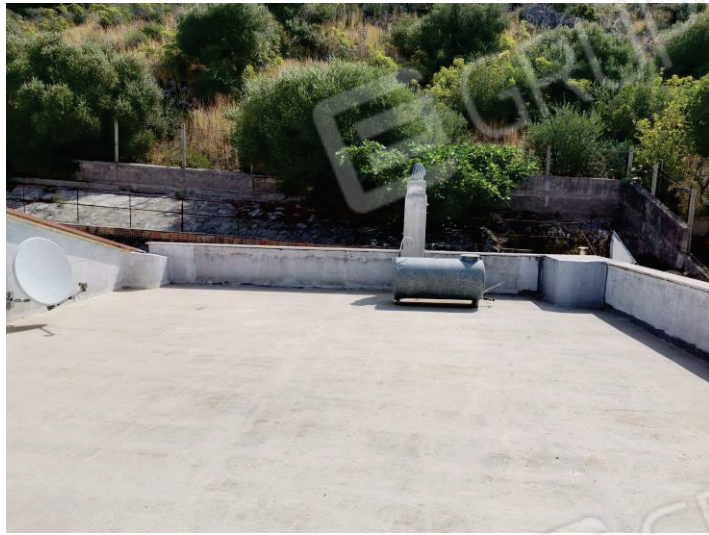
LOTTO 4 il lastrico solare sub 8
