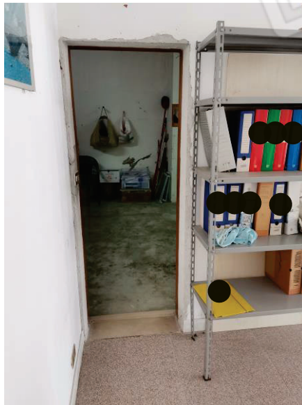
LOTTO 1 la porta che collega il sub 5 al sub 4
