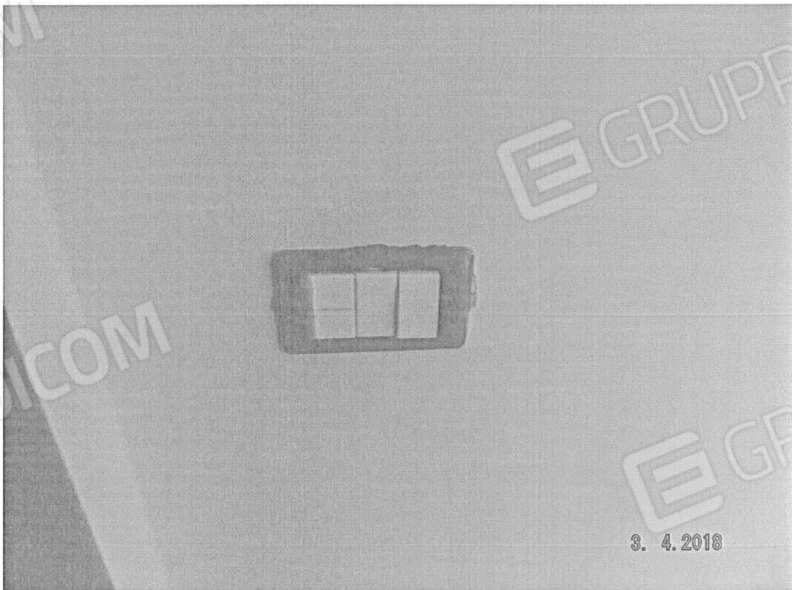
Figura 50: particolare impianto frutti
