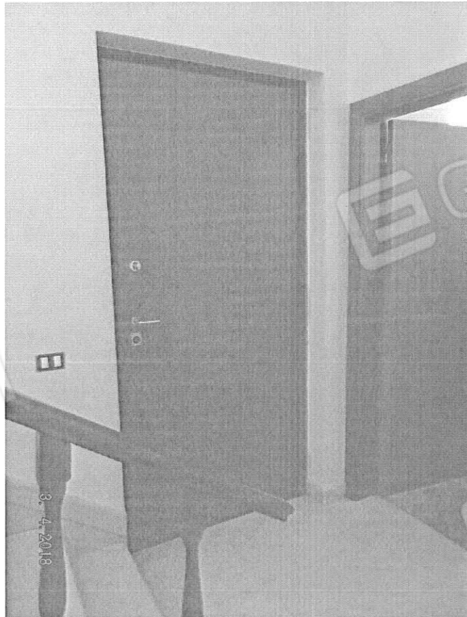
Figura 36: portone di accesso da via Pier Paolo Pasolini (vista dall'interno)
