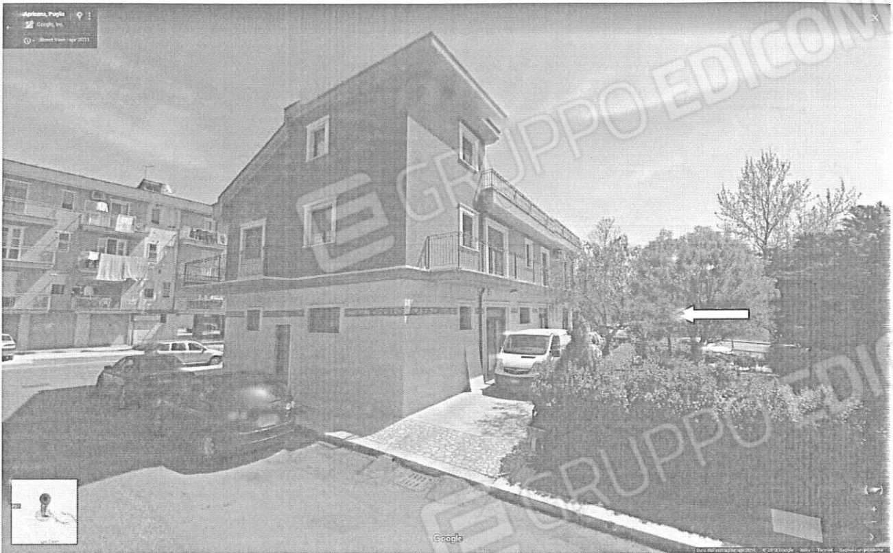
Figura 9: portone di accesso al piano II (al sub.2) da via Pier Paolo Pasolini
