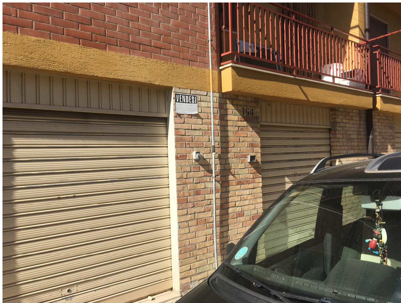
IMMAGINE 4: Comune di San Severo; saracinesca metallica di accesso all'immobile B
