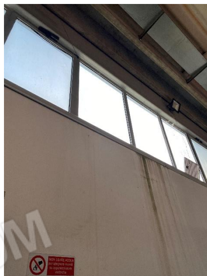
19-20-21-22. Interno: problematiche infiltrative in corrispondenza dei pluviali di scarico e di alcuni infissi.
