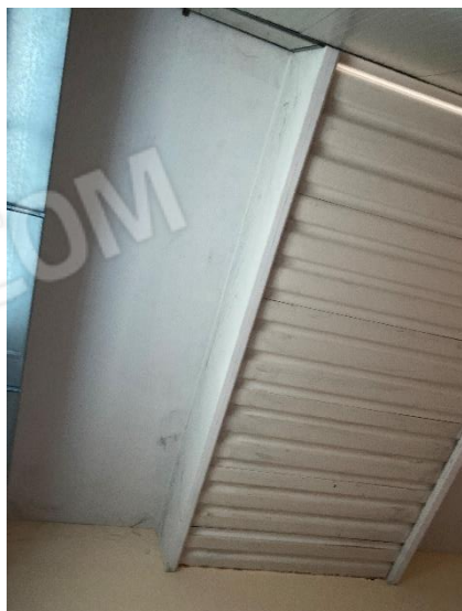
16-17-18. Interno: copertura con travi a doppia pendenza e tegoloni.
