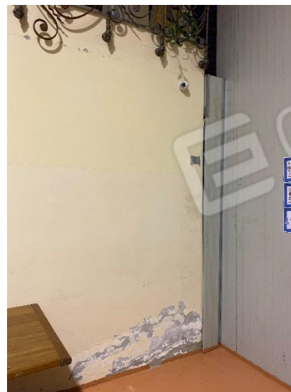
27-28. Interno: scala accesso uffici e risalita capillare alla base della scala.
