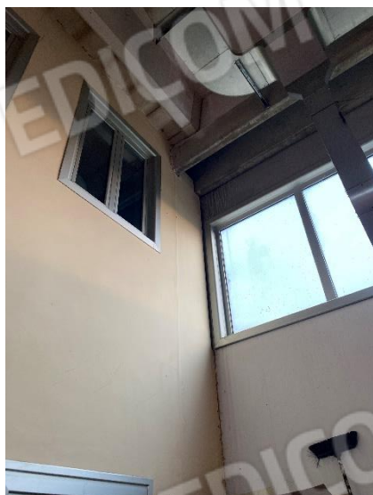
19-20-21-22. Interno: problematiche infiltrative in corrispondenza dei pluviali di scarico e di alcuni infissi.
