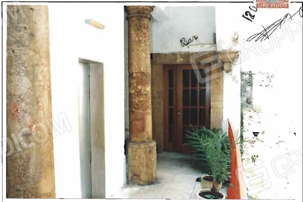
FOTO N°10 FOTO INGRESSO DEL BAR (1° PIANO)
