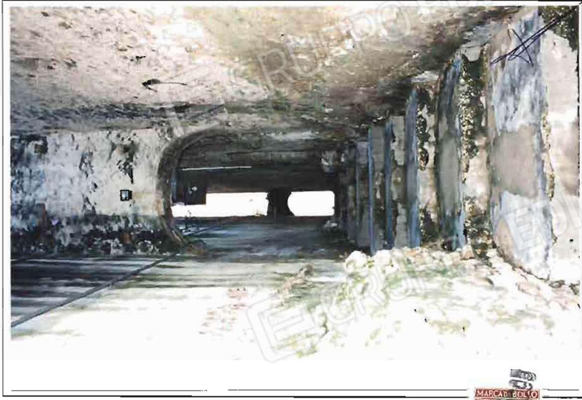
FOTO N°34 VISTA ARCO DI VIA FONTANELLA
