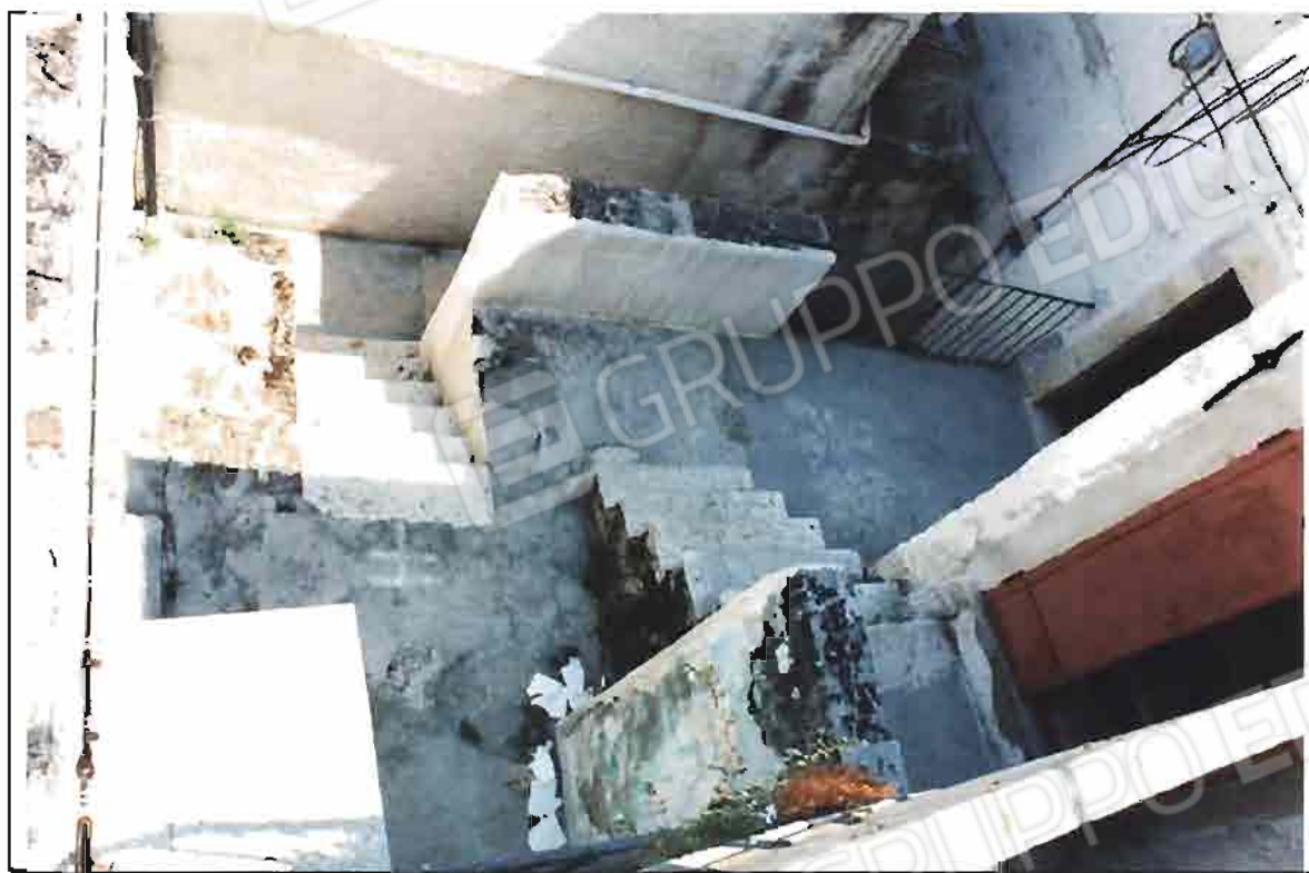
FOTO N°53 VISTA BALLATOIO TRA 3° E 4° PIANO
