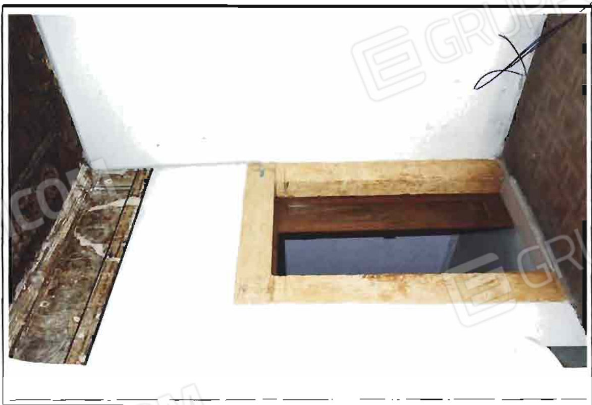
FOTO N°47 PORTA D'INGRESSO DEL III° LOTTO
