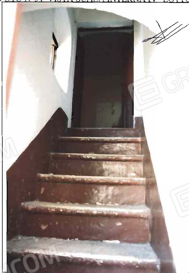
FOTO N°54 VISTA SCALA INTERNA IV° LOTTO
