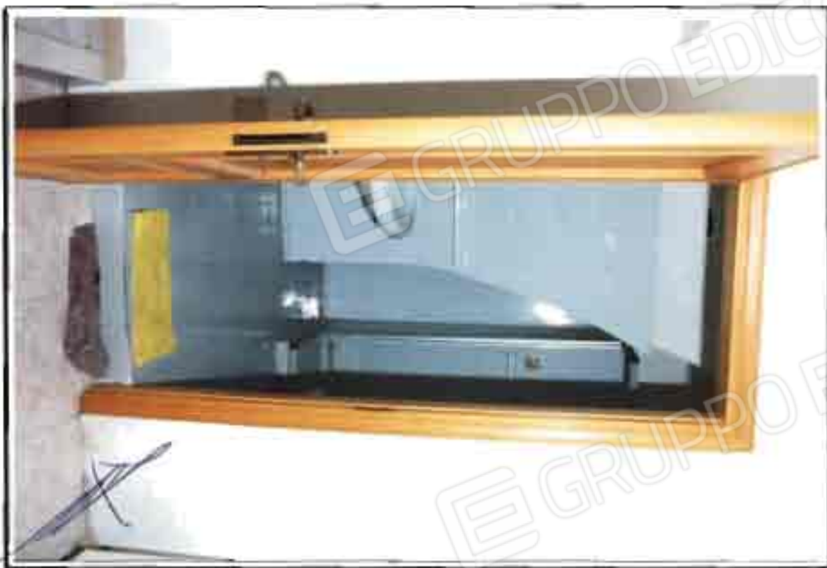
FOTO N°43 VISTA BAGNO II° LOTTO
