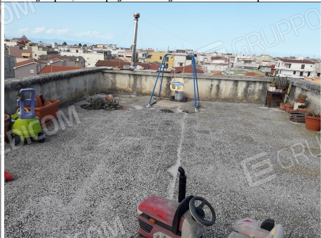
22 – Accesso al lastrico solare da botola, sita nel vano alla sinistra dell'appartamento in 2° p.
