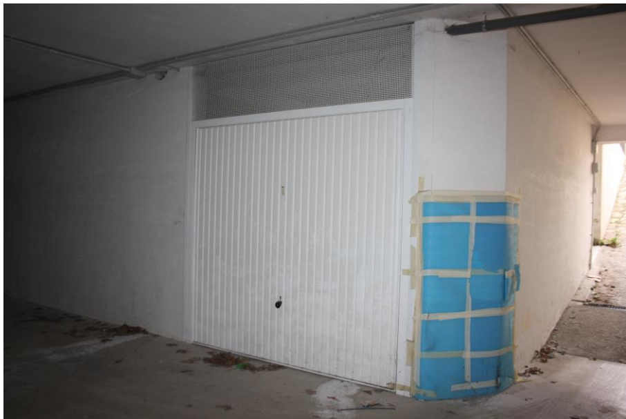
Accesso carraio al locale al grezzo del piano interrato
