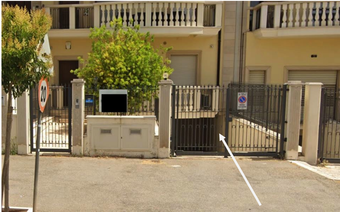
Rampa di accesso carraio
