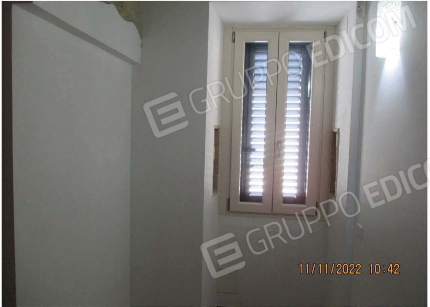
Foto n°9 - Ripostiglio piano primo
