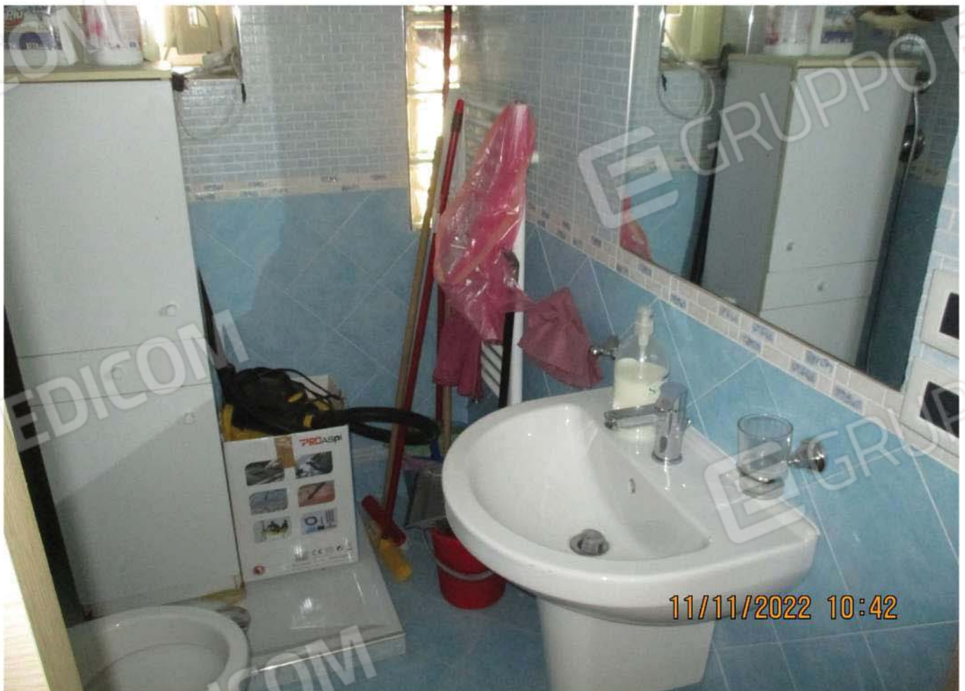
Foto n°10 - Bagno piano primo
