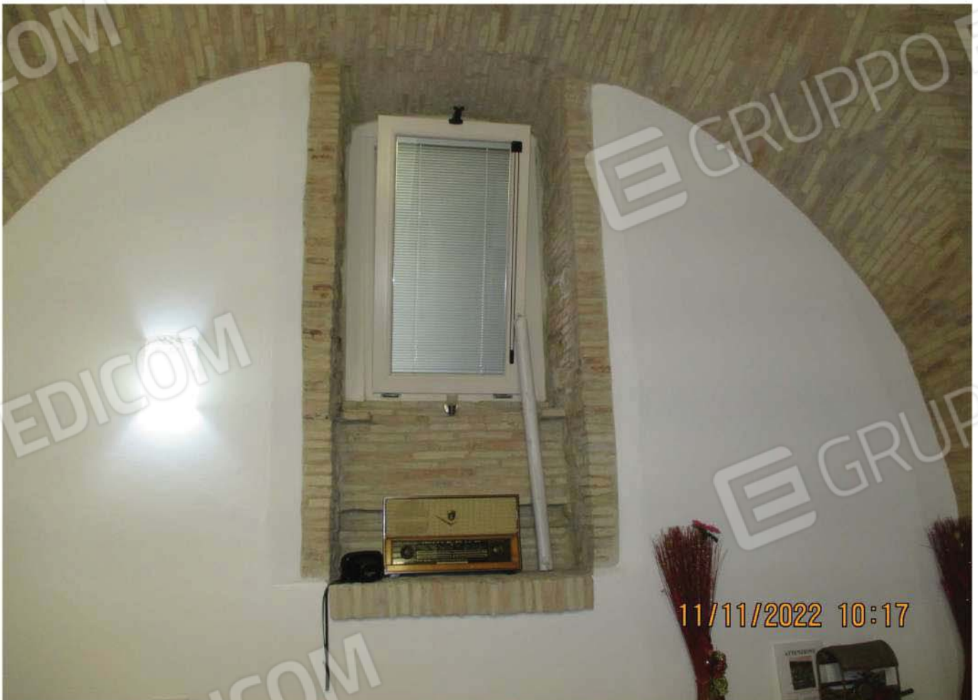
Foto n°6 - Ufficio piano terra
