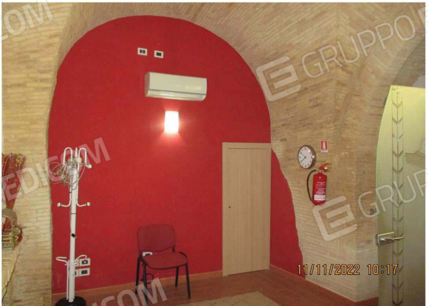
Foto n°4 - Ufficio piano terra
