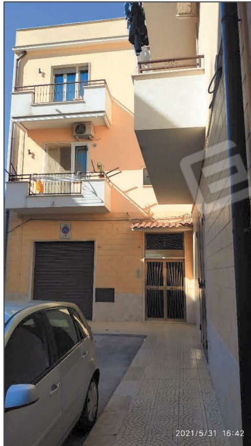
Foto 2 – Vista Prospetto sud
