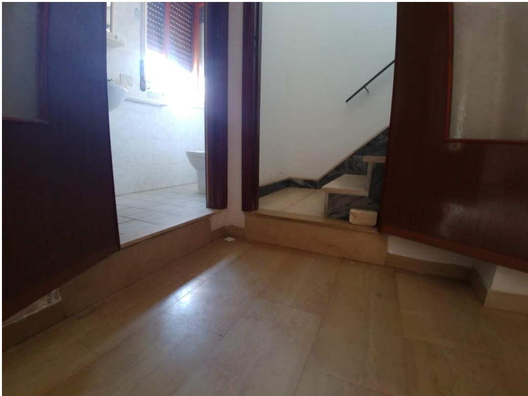
Figura 30: interno appartamento (scala di accesso al terrazzo)
