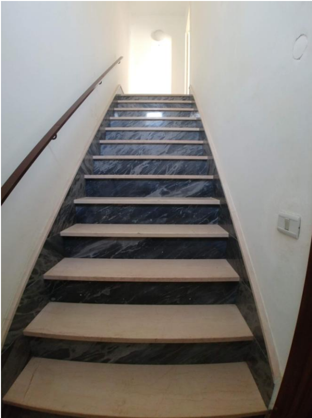
Figura 27: scala di accesso al terrazzo
