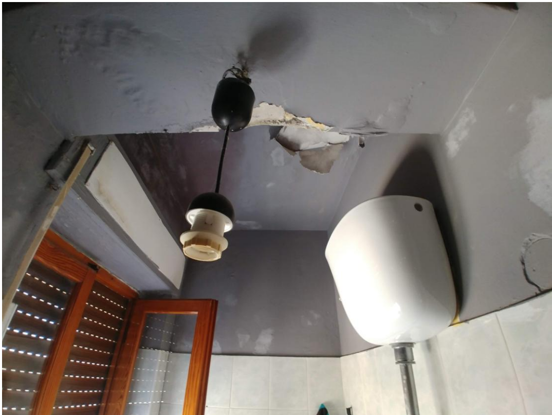
Figura 23: interno appartamento piano secondo (bagno)
