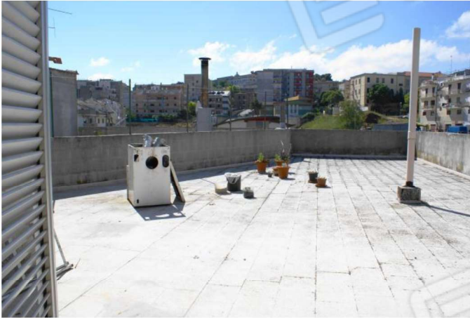
Foto n°34 Il lastrico solare
