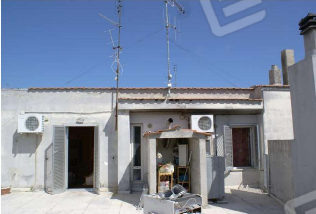
Foto n°37 A destra nella foto la finestra della camera foto n°28, al centro la finestra del bagno, a sinistra la porta balcone della camera da letto Genitori.
