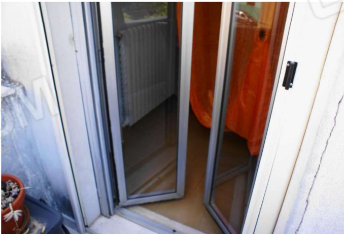
Foto n°17 Il balcone del soggiorno
