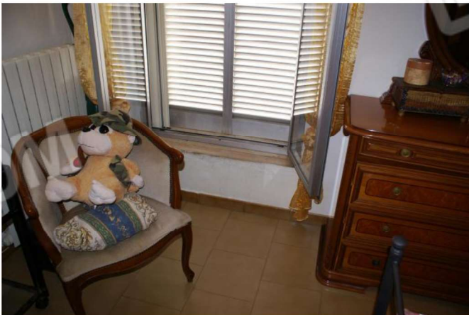
Foto n°32 Si noti come il lastrico solare ha un livello più alto rispetto al pavimento del vano
