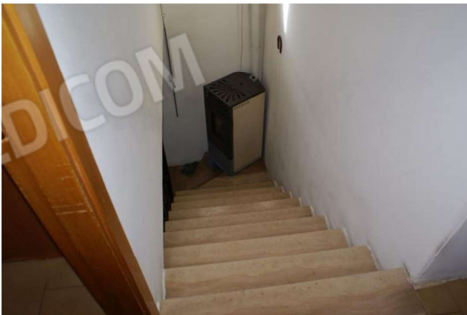
Foto n°21 La scala vista dal piano quarto
