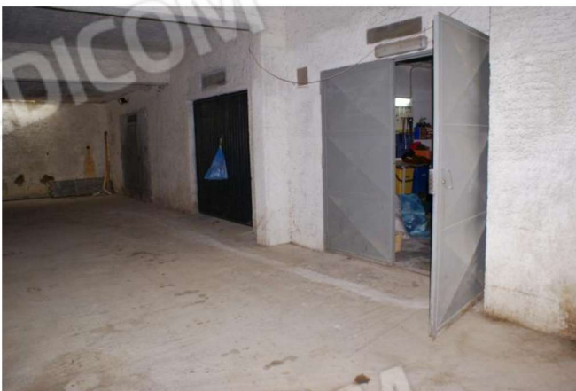
Foto n°39 La porta del box, a sinistra nella corsia di manovra si trova l'accesso
