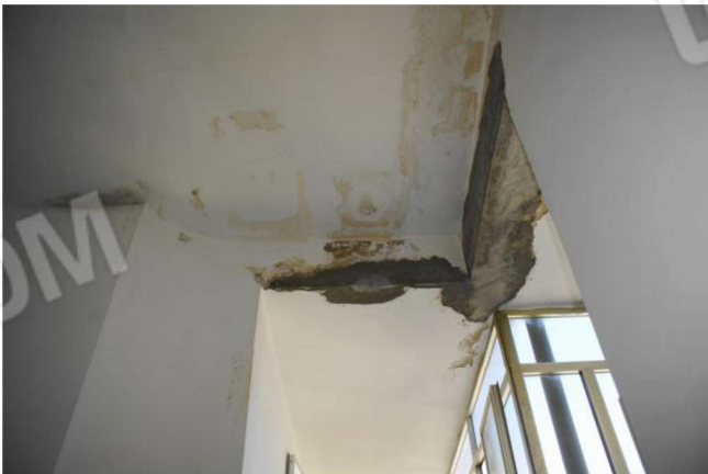
Foto n°8 Riprese nel soffitto sovrastante il pianerottolo
