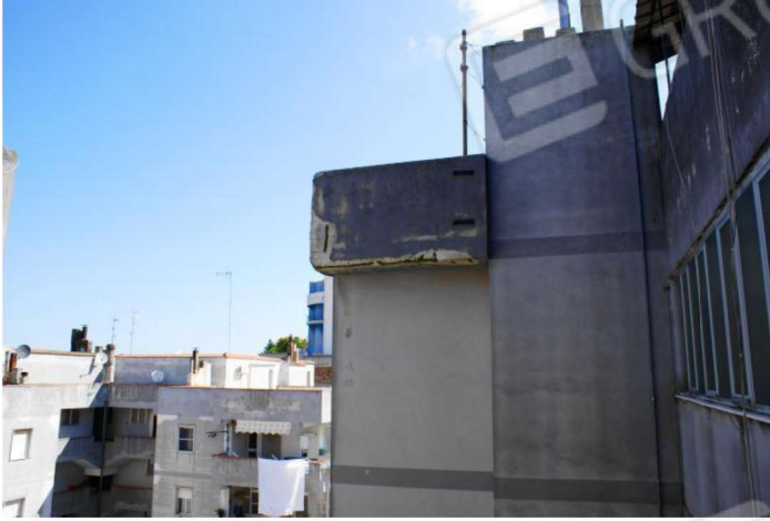
Foto n°10 Il parapetto del lastrico solare, visto dalle finestre delle scale
