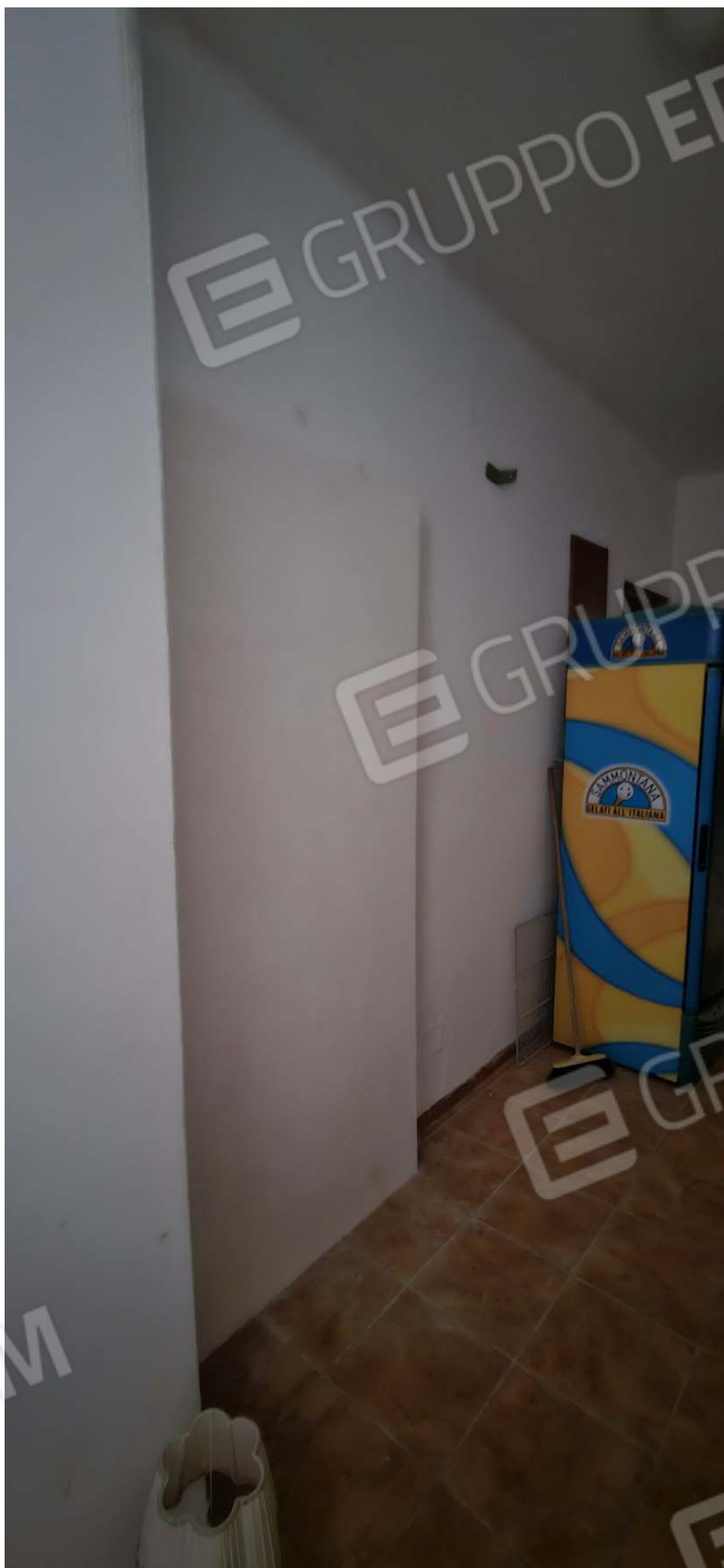
Vano difforme: magazzino piano primo
