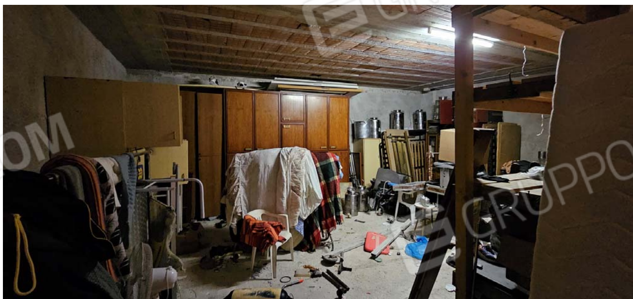
Vano difforme: deposito piano terra
