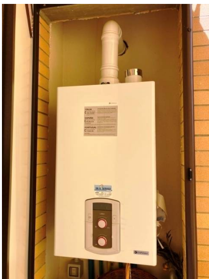
Figura 16 – Caldaia in vano tecnico sul balcone
