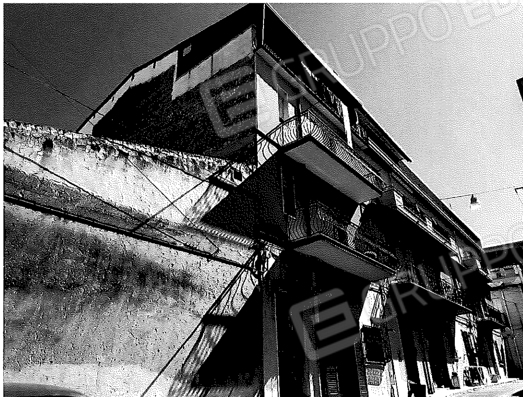
FOTO N. 1 – PROSPETTO SU VIA OVIDIO.
