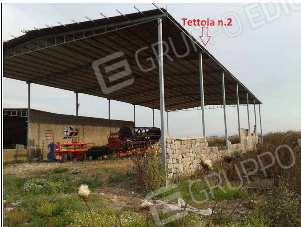
Foto n.47: sull'area adibita a corte, in evidenza i manufatti costituiti dalla tettoia n.2 ed i timpani murari in muratura, da notare la precarietà delle tettoie e dei manufatti murari slegati dalle strutture metalliche.
