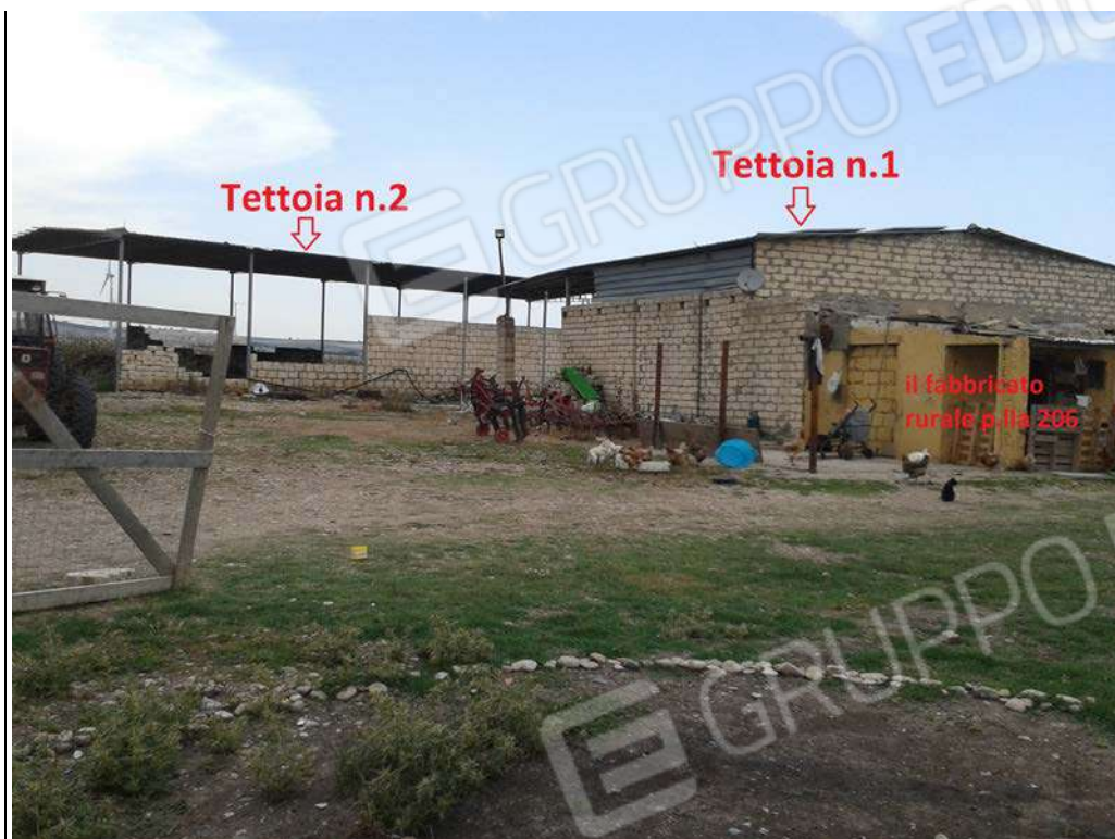
Foto n.45: sull'area adibita a corte, in evidenza i manufatti costituiti dalle tettoie n.1 e n.2, il fabbricato rurale p.lla 206, da notare la precarietà delle tettoie e dei manufatti murari slegati dalle strutture metalliche.
