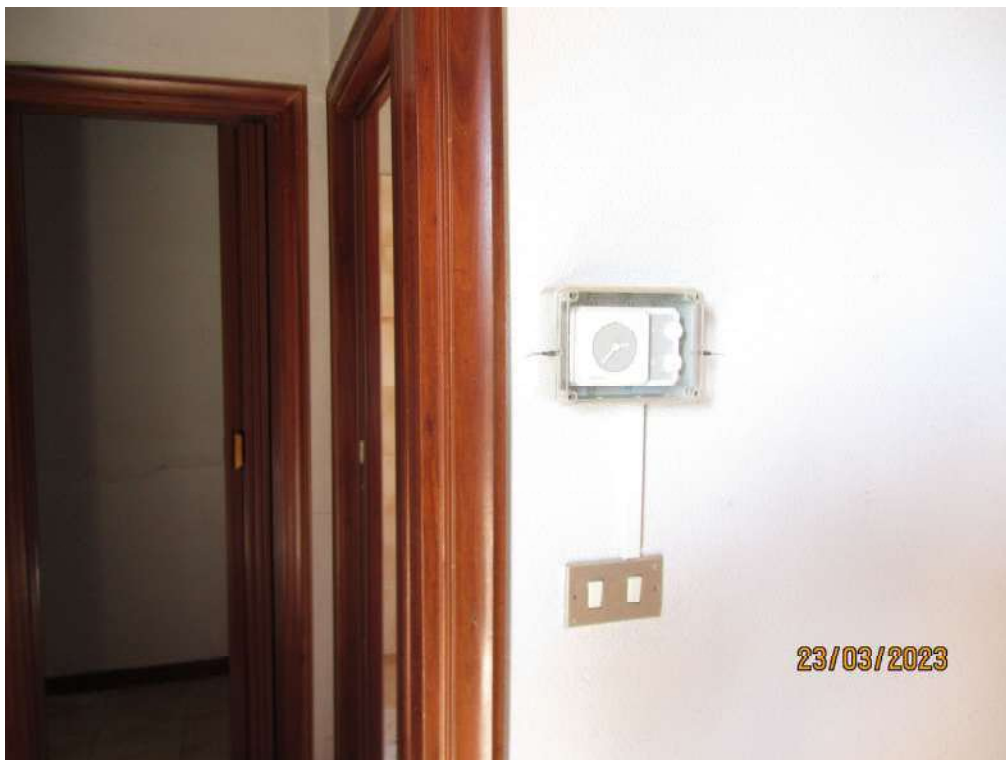
FOTO 6 - Cronotermostato caldaia.
