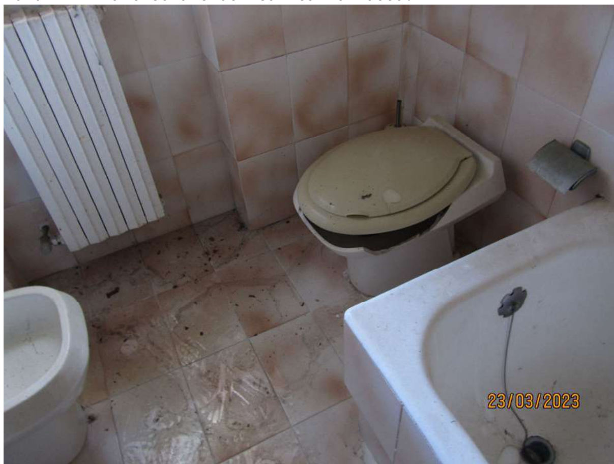
FOTO 12 - Particolare del sanitario rotto.
