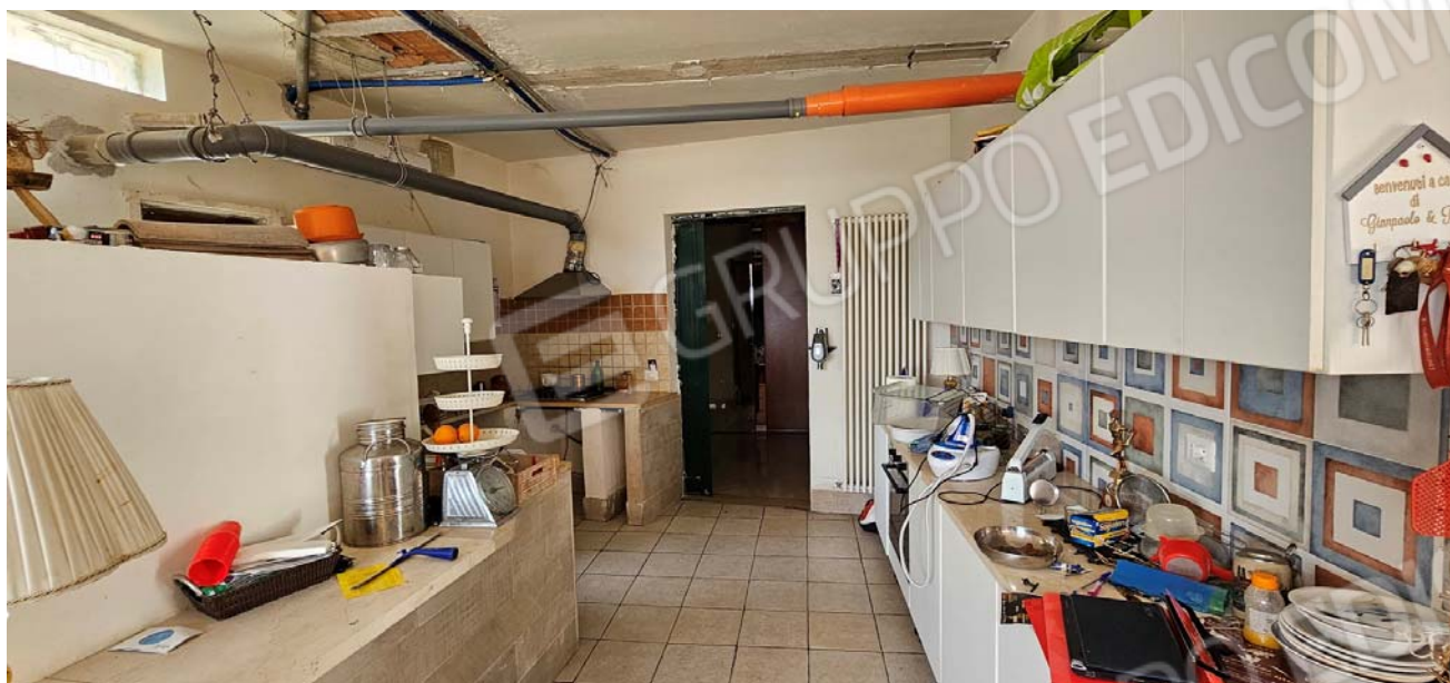
Vano difforme: alloggio, piano terra
