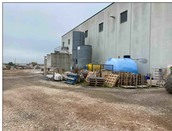
Cisterna per accumulo acqua potabile da 20.000 l e vasca di riciclaggio delle acque di lavorazione della pietra.
