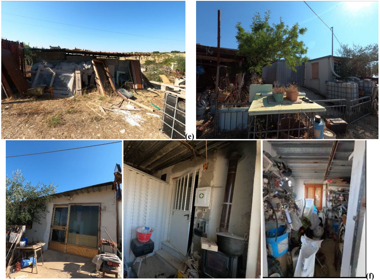
Figura n° 5. Fotografie del BENE B: stradone comodale privato di accesso (a); recinzione e cancelli metallici (b); piazzale (c); porzione di terreno agricolo adibito a mandorleto (d); tettoie e strutture precarie (e); fabbricato rurale (f).
