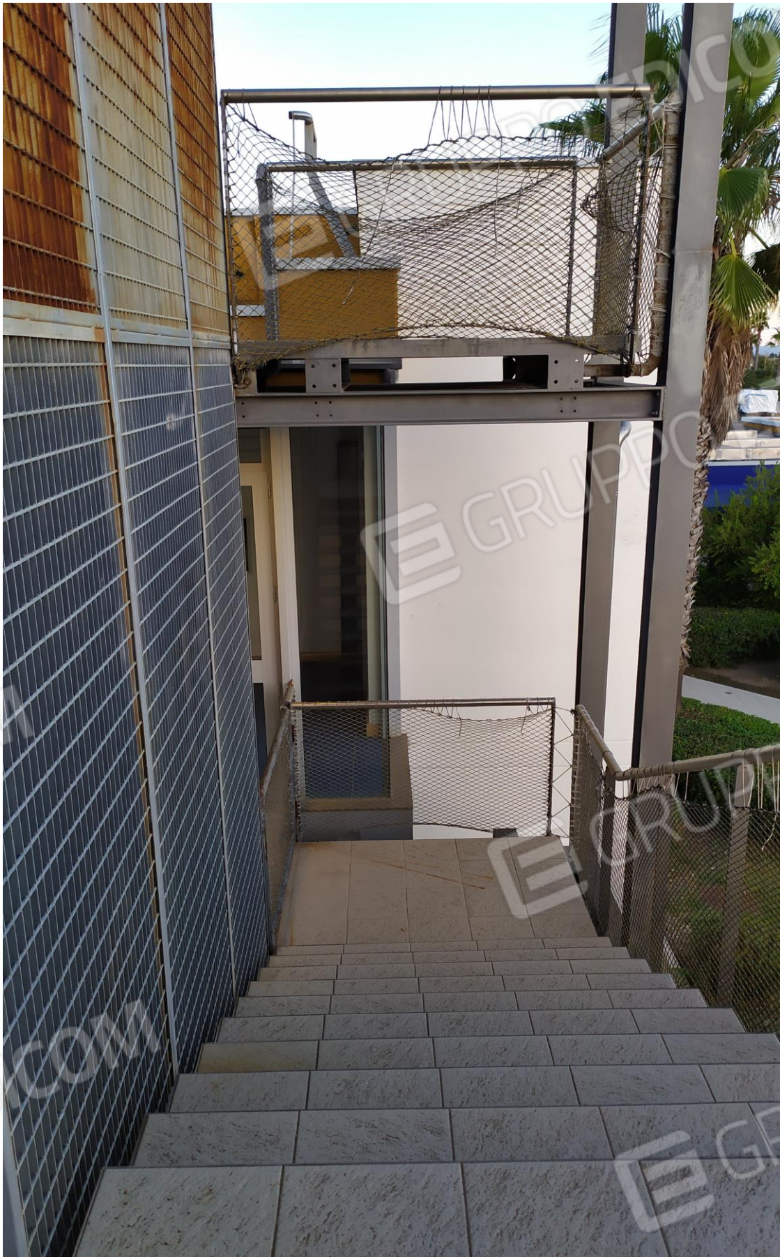
FOTO Imp.20: in evidenza, la scala metallica prefabbricata che consente l'accesso esternamente sulle coperture piane per la manutenzione delle stesse e degli impianti tecnologici ivi installati.
