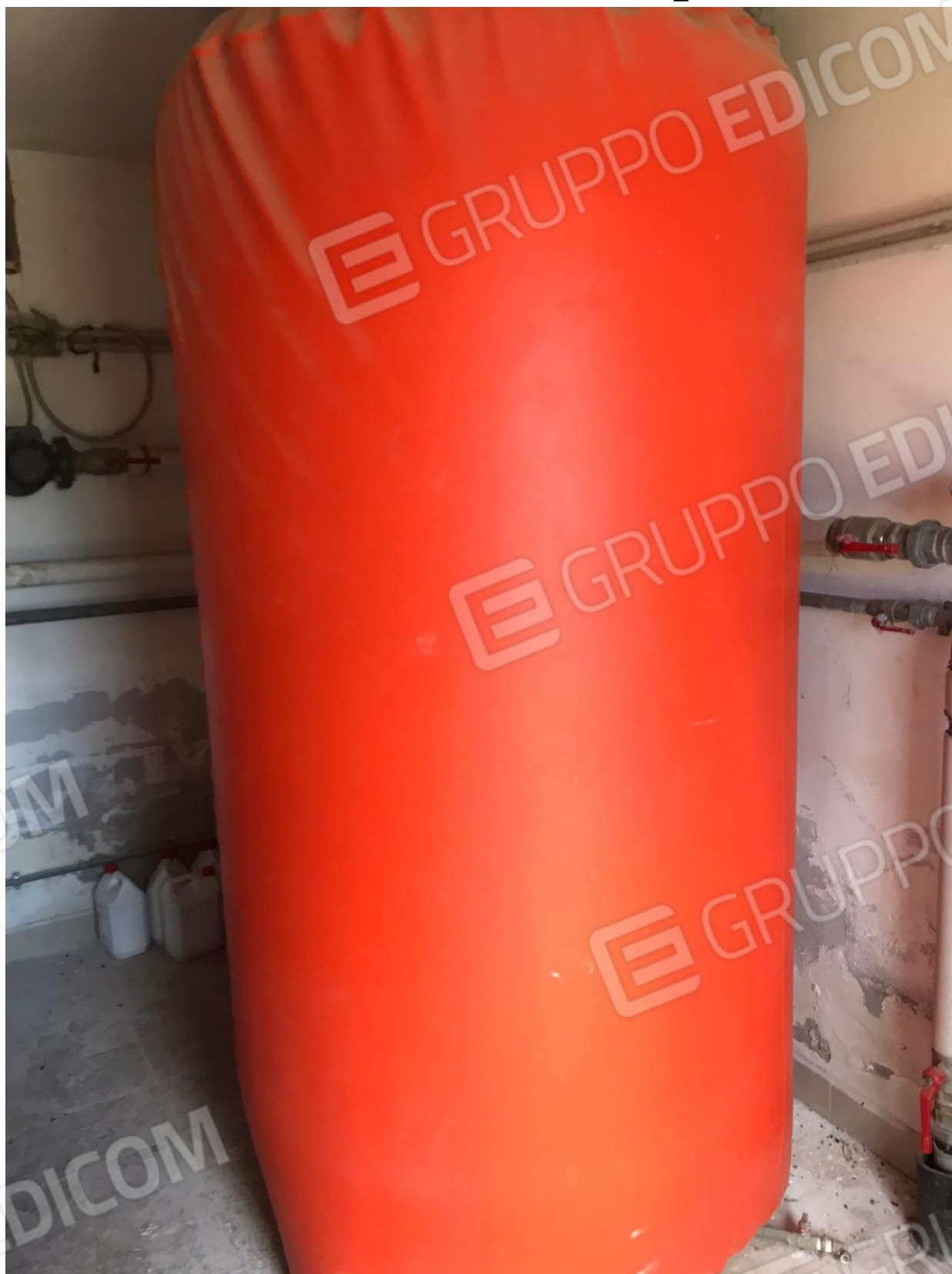
FOTO Imp.6: in evidenza, nel vano Centrale Termica parte degli impianti di riscaldamento ed acqua calda sanitaria ed il serbatoio di accumulo della stessa.
