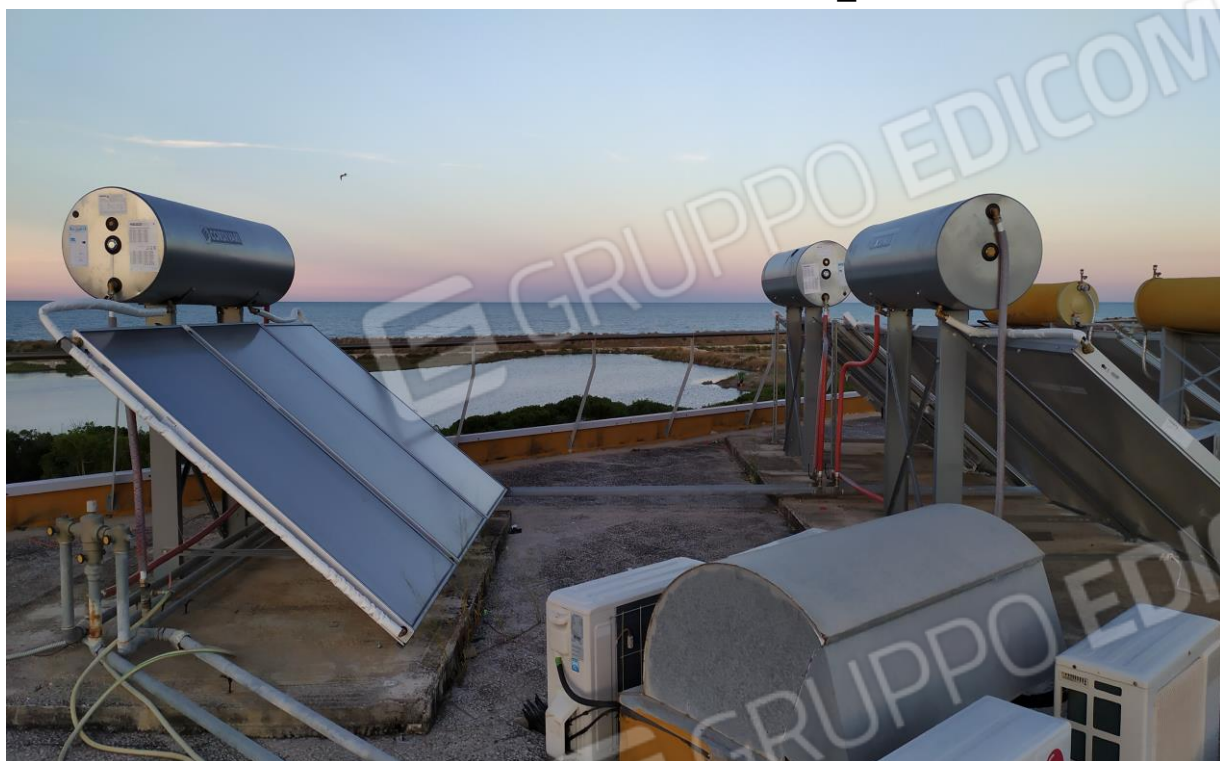
FOTO Imp.15: in evidenza, esternamente sulle coperture piane, parte degli impianti tecnologici di climatizzazione ed i pannelli solari per l'acqua calda sanitaria con serbatoi di accumulo.
