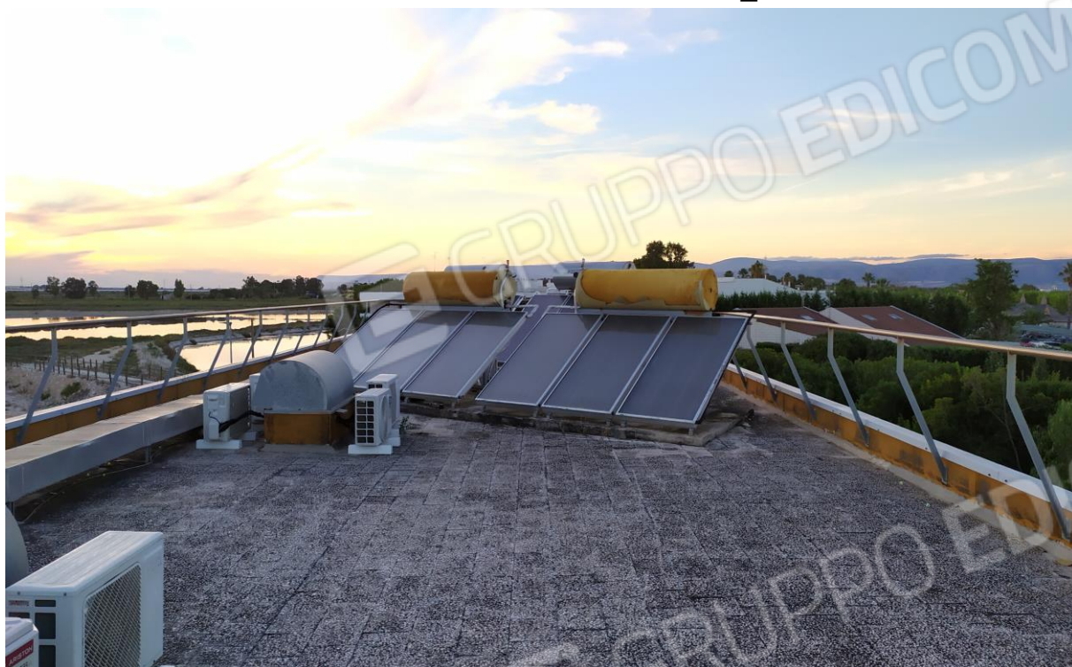
FOTO Imp.17: in evidenza, esternamente sulle coperture piane, parte degli impianti tecnologici di climatizzazione ed i pannelli solari per l'acqua calda sanitaria con serbatoi di accumulo.
