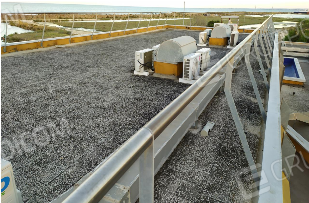
FOTO Imp.10: in evidenza, esternamente sulle coperture piane, parte degli impianti tecnologici di climatizzazione.
