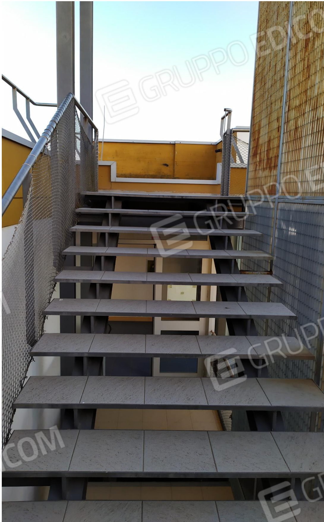
FOTO Imp.19: in evidenza, la scala metallica prefabbricata che consente l'accesso esternamente sulle coperture piane per la manutenzione delle stesse e degli impianti tecnologici ivi installati.
