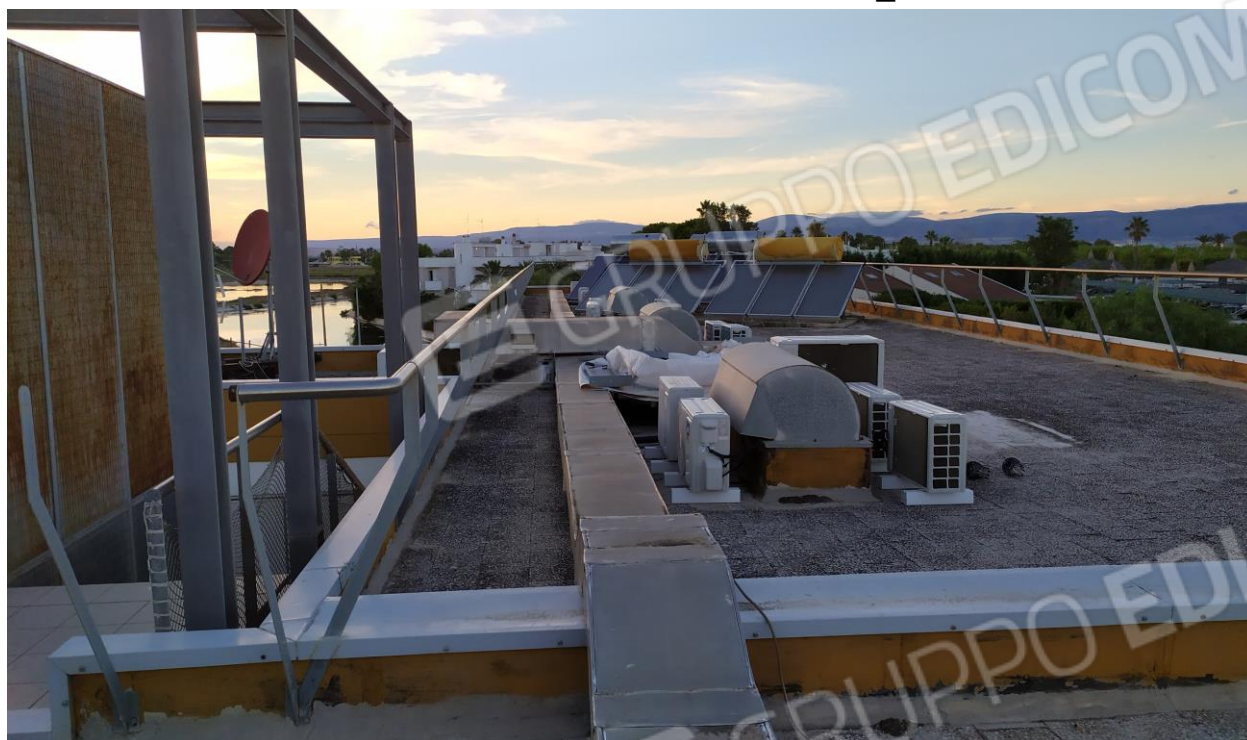
FOTO Imp.11: in evidenza, esternamente sulle coperture piane, parte degli impianti tecnologici di climatizzazione ed i pannelli solari per l'acqua calda sanitaria con serbatoi di accumulo.
