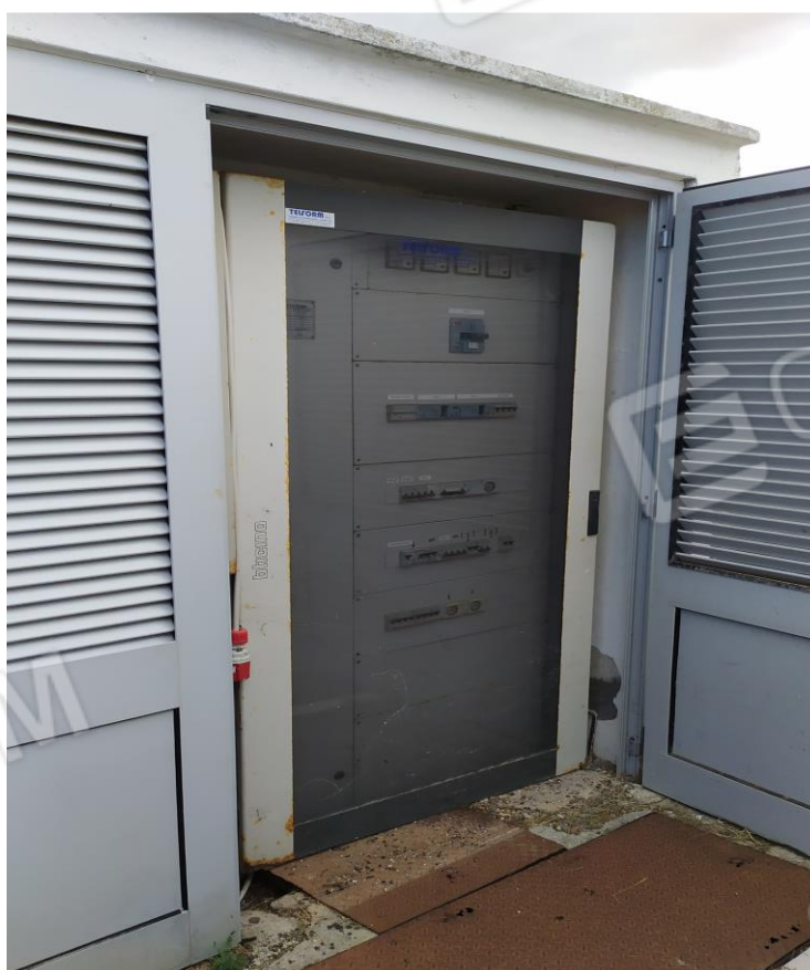
FOTO Imp.8: in evidenza, esternamente a sud e nei pressi dell'Hotel internamente all'area recintata, i quadri elettrici annessi al gruppo elettrogeno contiguo.
