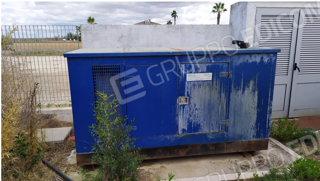
FOTO Imp.7: in evidenza, esternamente a sud e nei pressi dell'Hotel internamente all'area recintata, il gruppo elettrogeno ed i contigui quadri elettrici.
