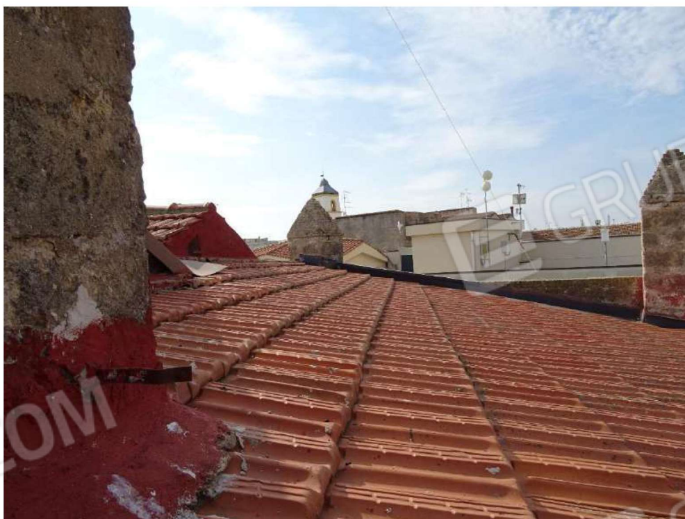
Foto n. 30 Copertura a falda inclinata con tegole marsigliesi
