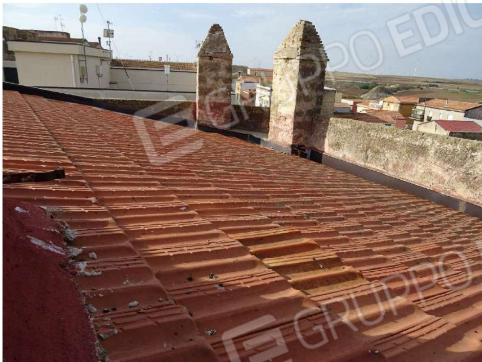
Foto n. 29 Copertura a falda inclinata con tegole marsigliesi
