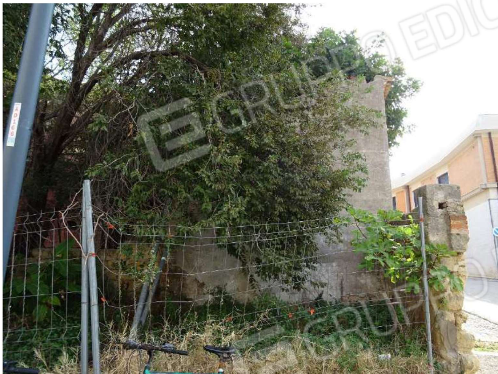
Foto n. 15 Foto prospetto Via Attilio Lombardi
