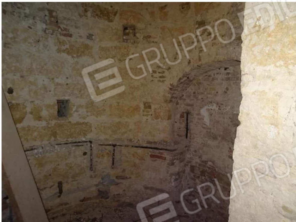
Foto n. 13 Bagno presente all'interno della 1° stanza
