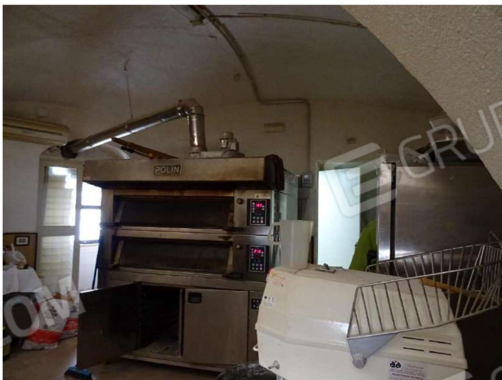
Foto n. 10 Interno zona laboratorio
