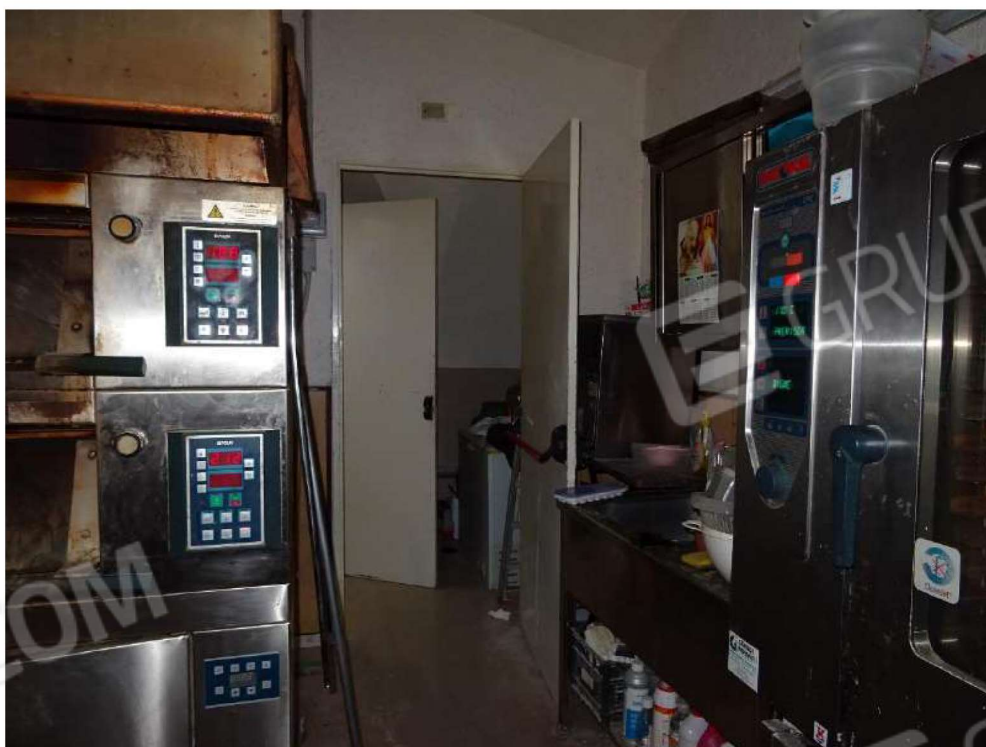
Foto n. 8 Interno zona laboratorio
