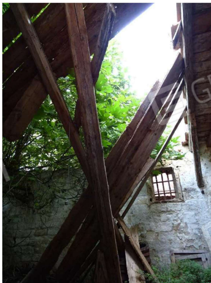
Foto n. 16 Foto interno particella 2484
