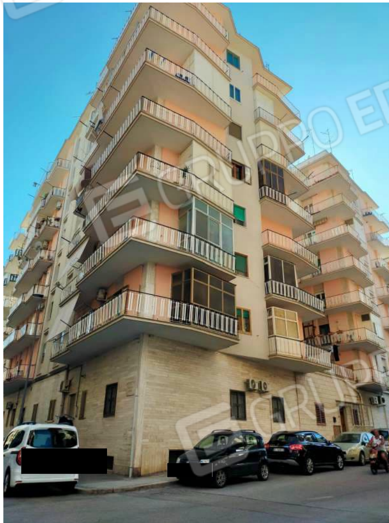
Vista esterna dell'edificio
