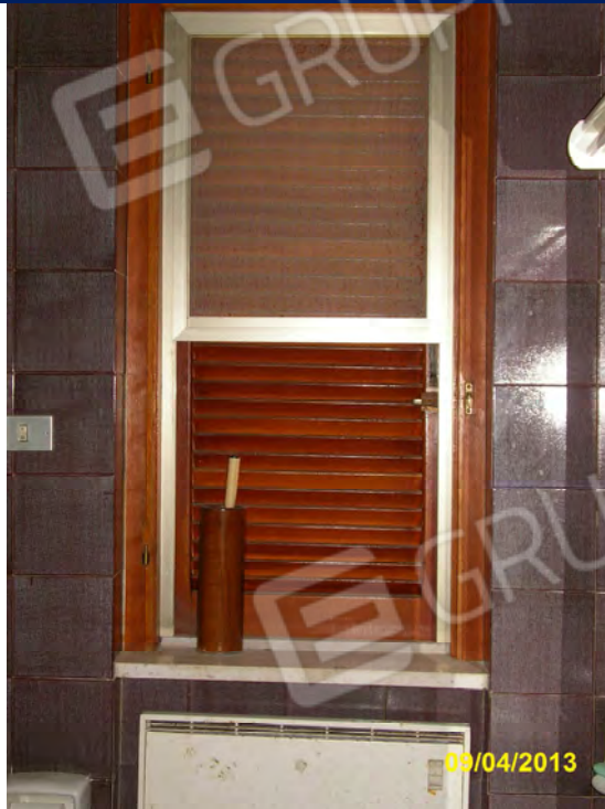
21 - Interno proprietà [REDACTED]: infissi interni
