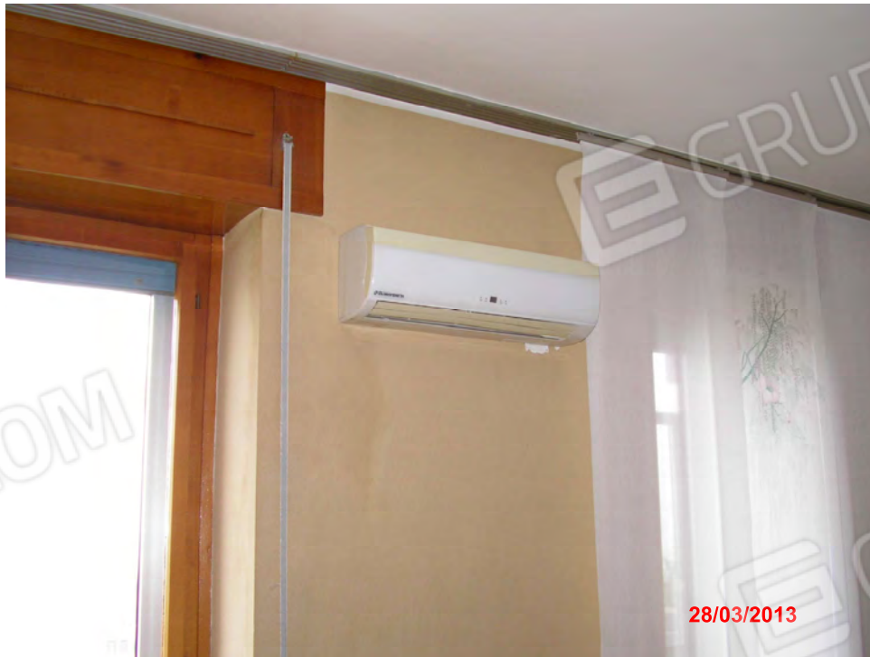
6 – Particolare infissi esterni (2)
