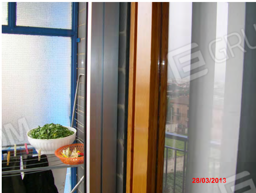
10 - Particolare infissi esterni (3)
