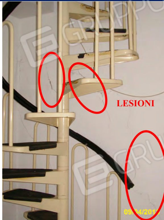
9 - Interno proprietà [redacted] : scala, lesioni
